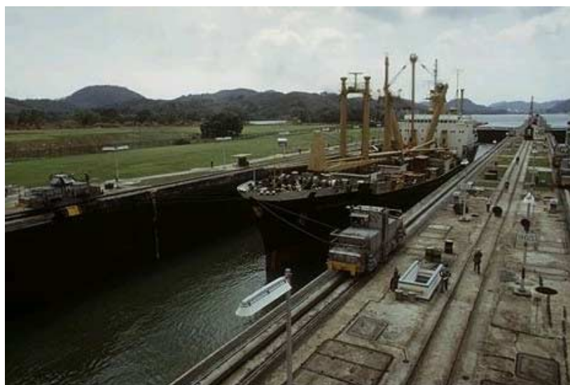
Obrázok 14.4 Panamský prieplav. Lode prekonávajú výškový rozdiel až 82 metrov pomocou systému stavidiel a nádrží.
