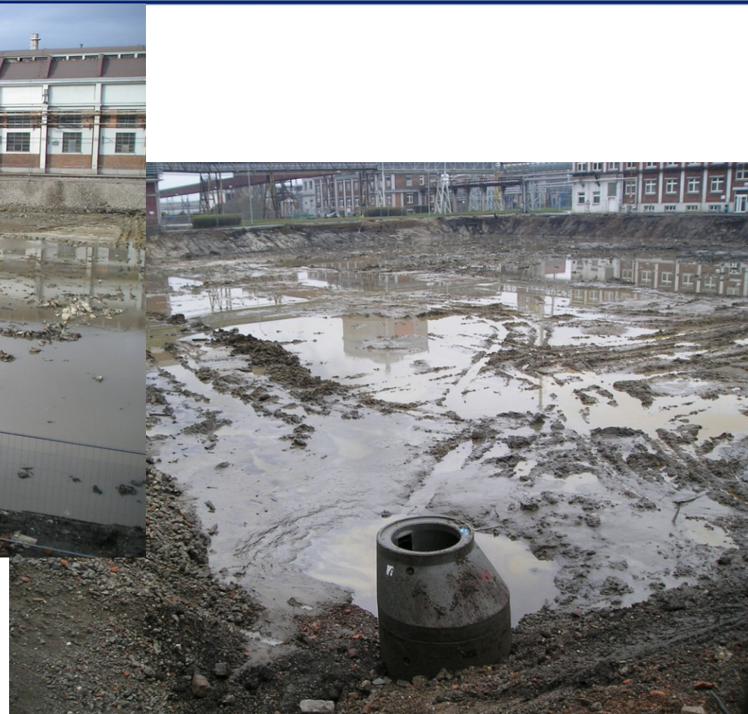
SO 01 - Objekt technických plynů-sanační výkop zemin
