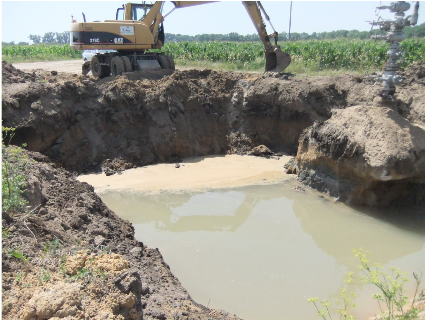
Sonda HR76-sanační výkop s obnaženým zhlavím sondy
