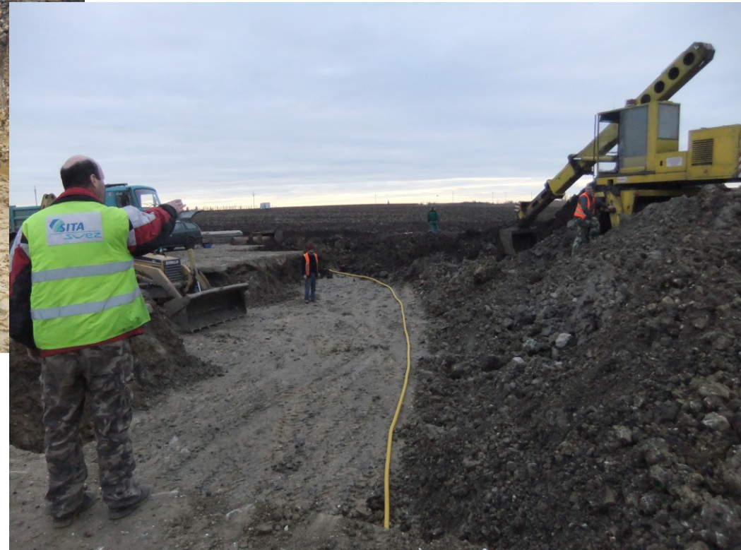
Sonda HR138-obnova meliorační drenáže
