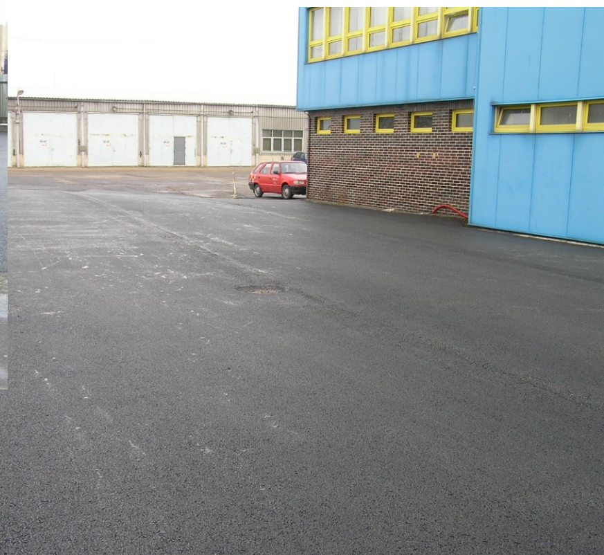
Obnova zpevněného asfaltového povrchu
