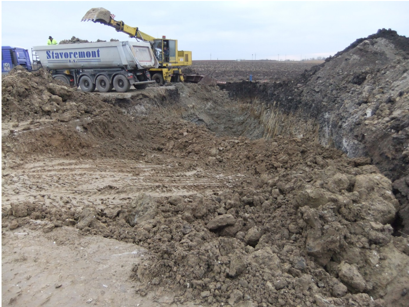
Sonda HR138-sanační těžba a nakládka kontaminovaných zemin
