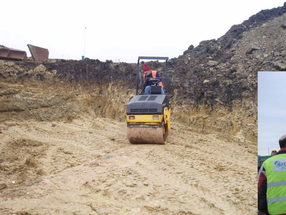
Sonda HR138-hutnění zásypu výkopu
