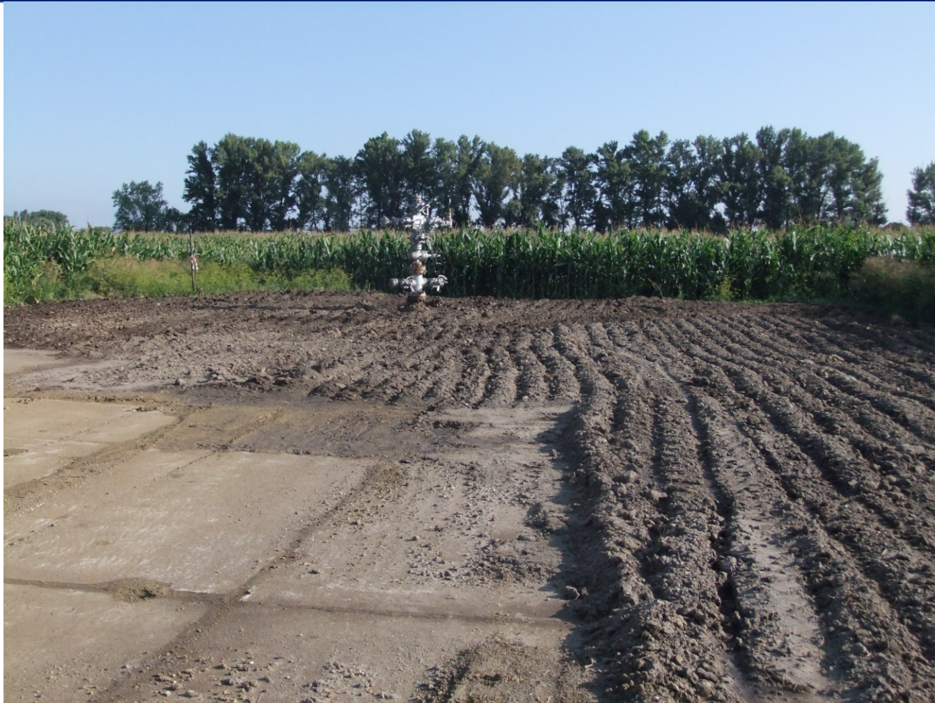
Sonda HR76-plocha sanace po technické rekultivaci
