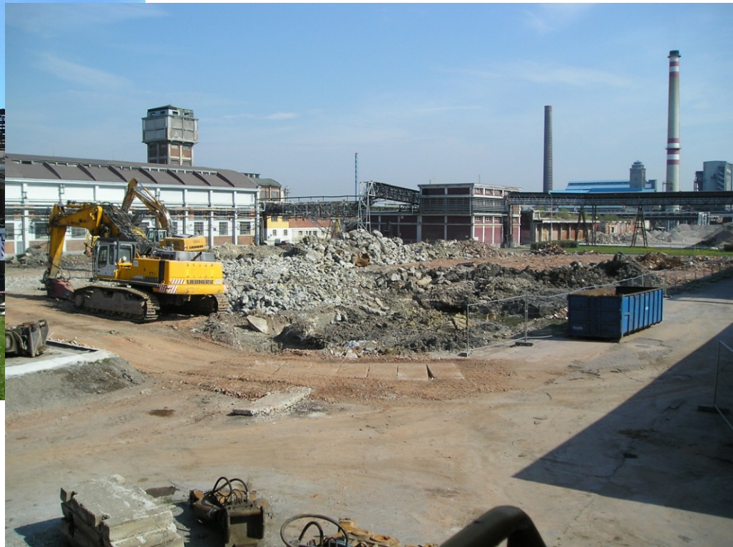
SO 01 - Objekt technických plynů-demolice
