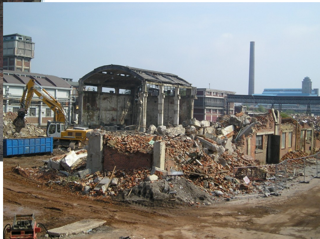
SO 01 - Objekt technických plynů-demolice
