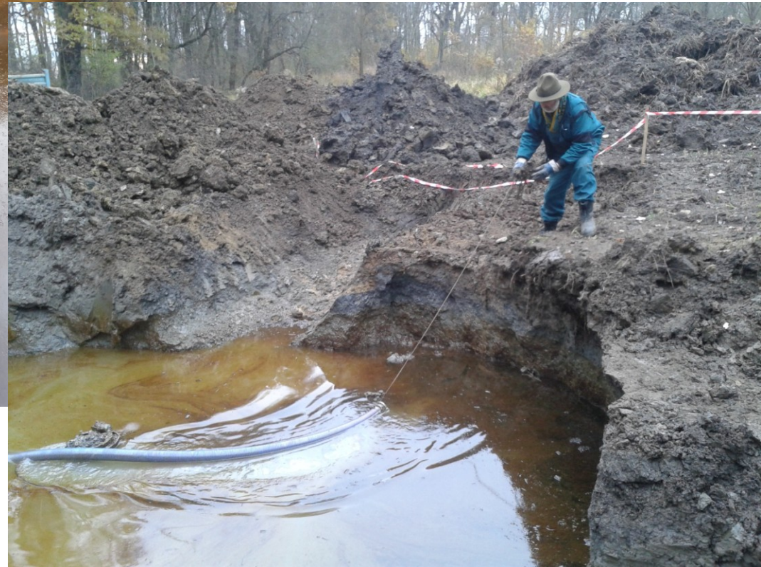
Sonda KO7-sanace podzemní vody sčerpáváním volné fáze RL z hladiny
