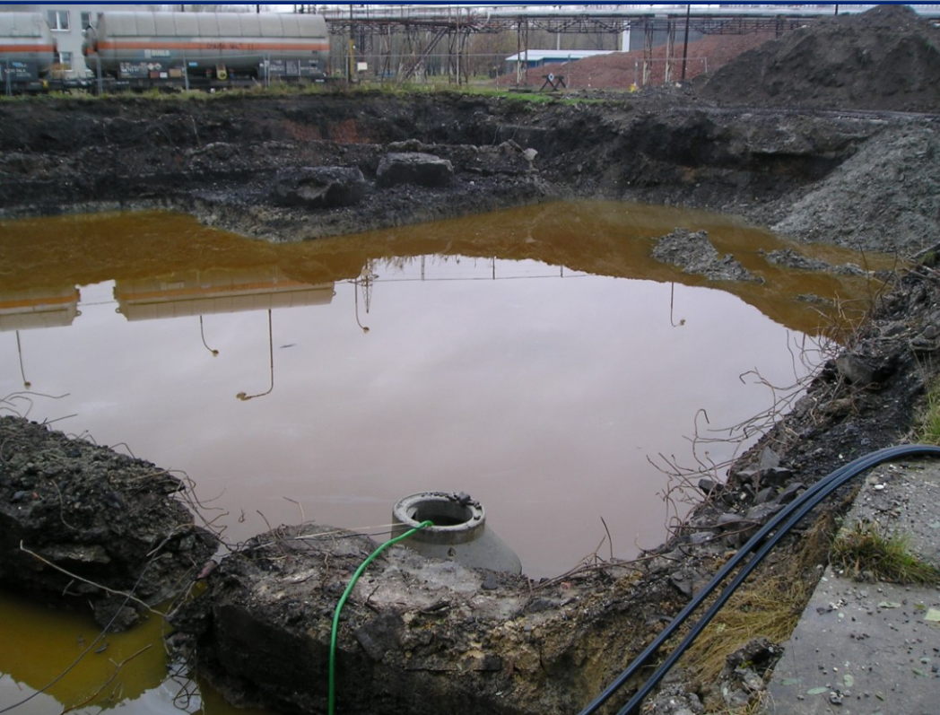
SP-05 - bývalé tankoviště cyklohexanonu – sanační výkop s čerpací šachticí
