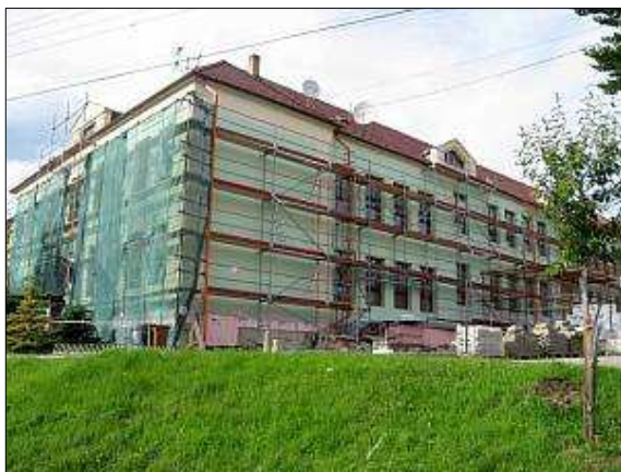
Obr. 83 Dambořice – rekonstrukce základní školy. Foto Z. Lipovská
