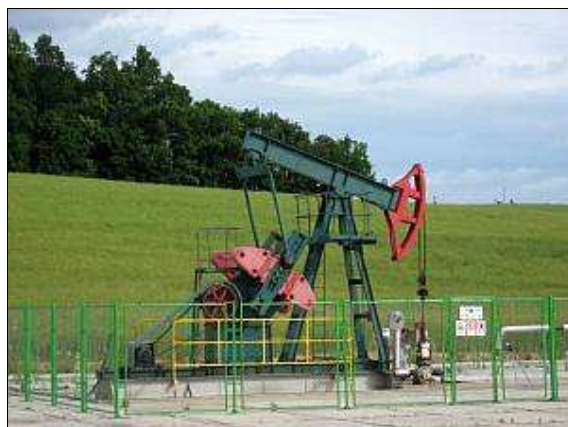
Obr. 82 Dambořice – kozlík. Foto Z. Lipovská
