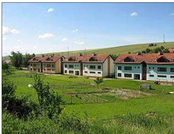
Obr. 84 Dambořice – nová výstavba. Foto Z. Lipovská
