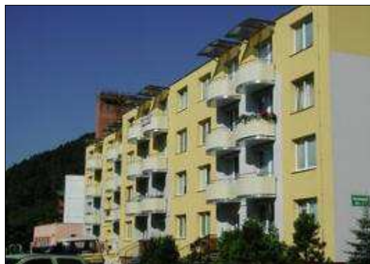
Obr. 11 Tišnov – rekonstruovaná panelová zástavba. Foto A. Vaishar
