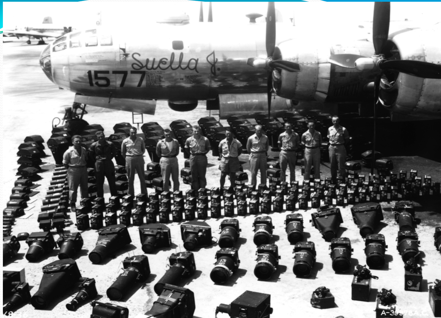
Boeing B-29 a jeho fotogrammetrická výbava, 1946
