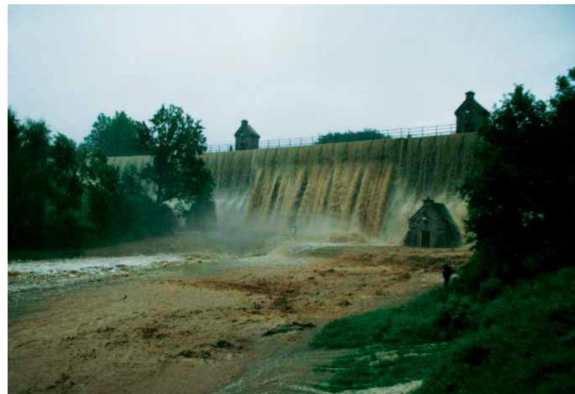
Přelévání hráze VD Mlýnice v povodí Lužické Nisy
