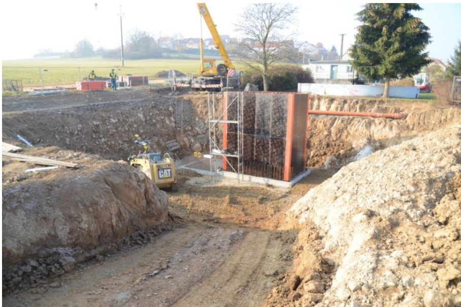
Foto 2.3 - stavba přečerpávací stanice Rudice
