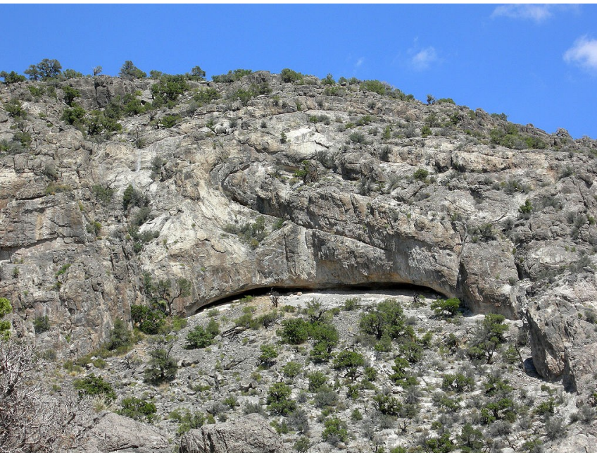
vápence porušené impaktem
