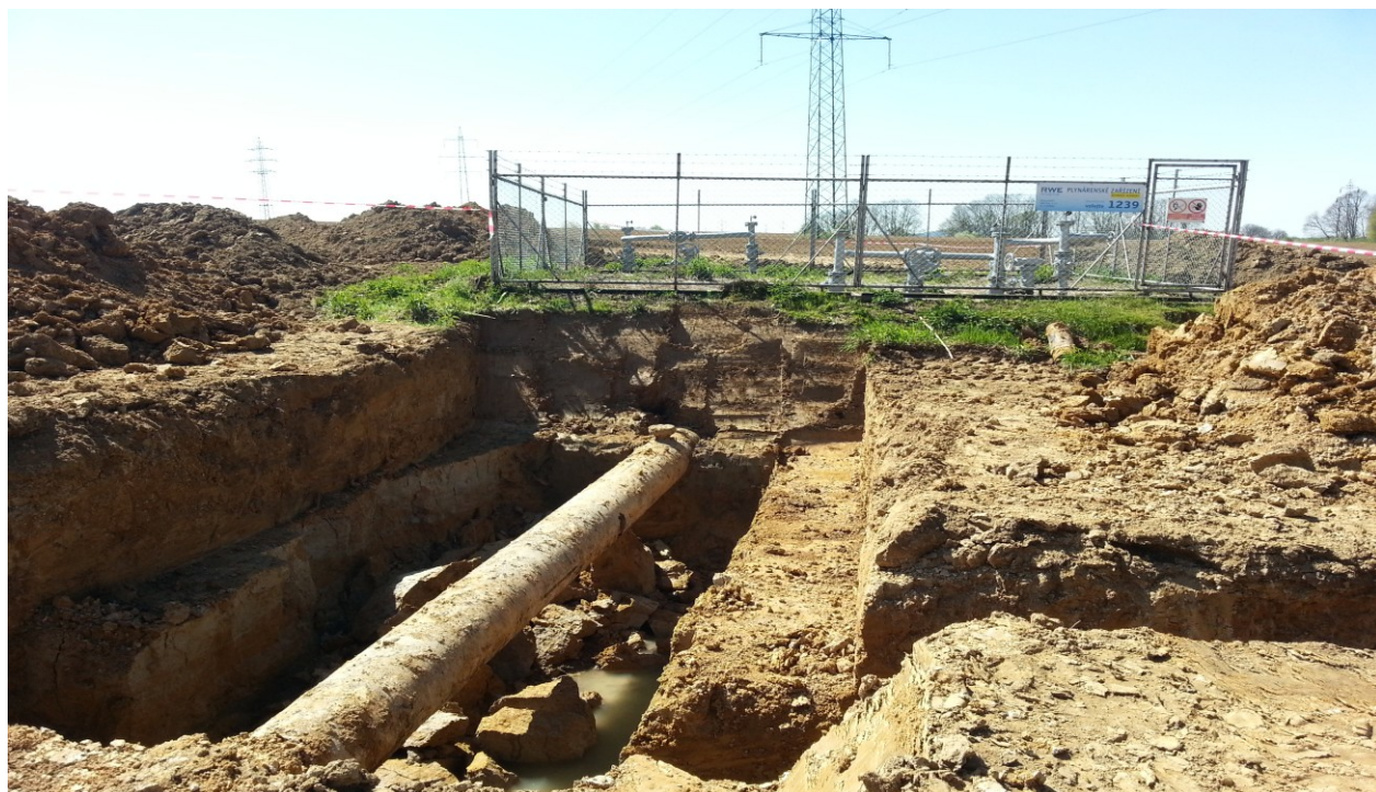
Obr. 38 Odkrytý plynovod (autor: Mořic Jurečka, duben 2016)
