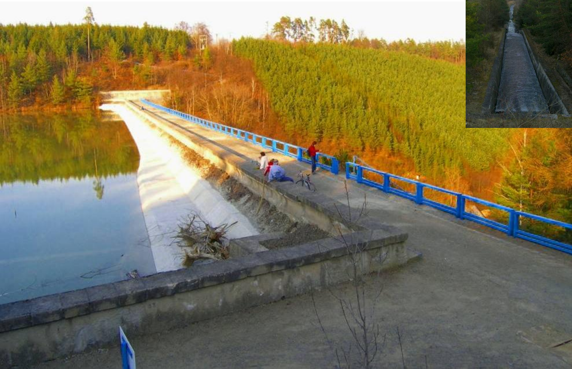
Málo známá Opatovická přehrada na Malé Hané, dokončena r. 1972, plocha 70 ha, hráz vysoká 42 m, zdroj pitné vody pro Vyškov a okolí
