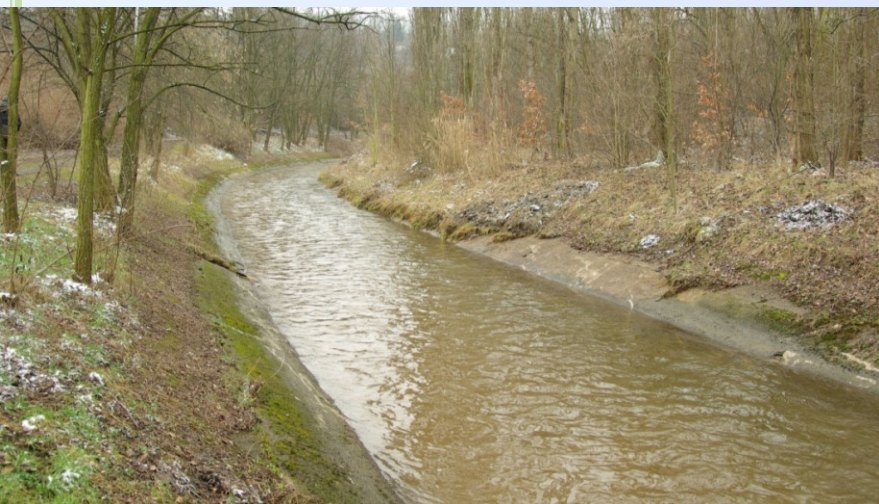
Staré betonové koryto:
