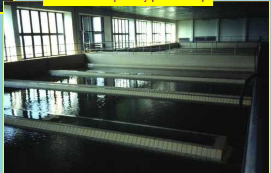
Pitná voda úpravny pitné vody
