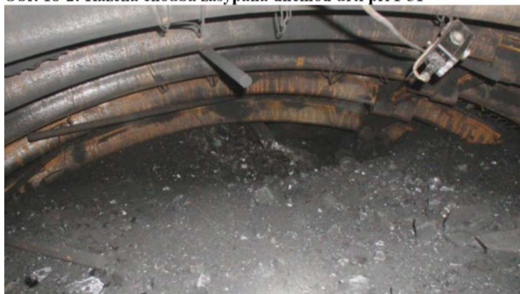
Obr. 18-2: Ražená chodba zasypaná uhelnou drtí při PUP
