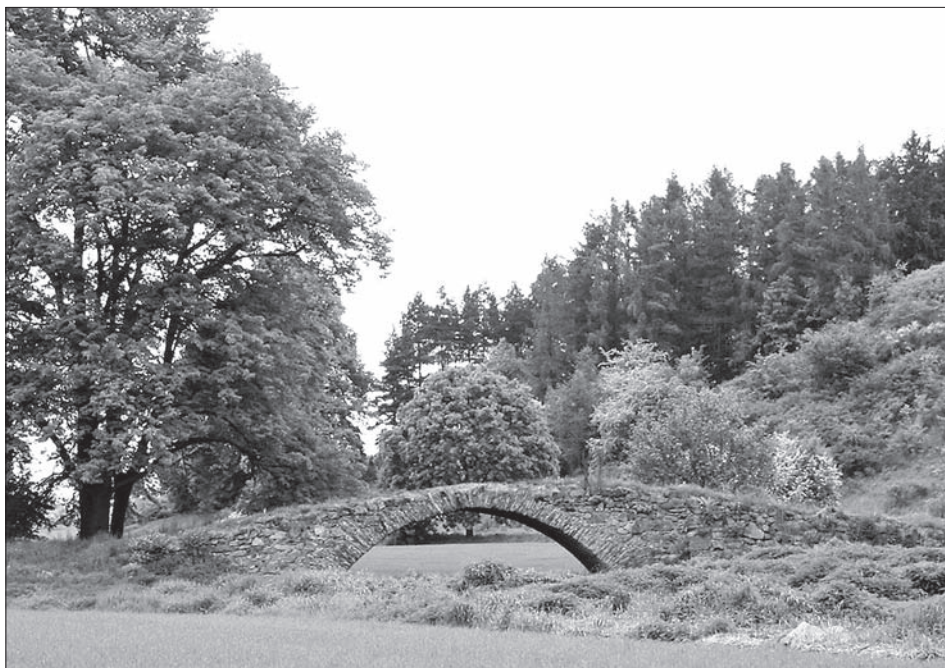
Obr. 2 Žižkův most. Přeložení koryta Březového potoka v povodí Otavy po regulaci ve 20. letech 20. století zanechalo původní středověký most na suchu, mimo současné koryto toku. Foto J. Langhammer, 2003.
