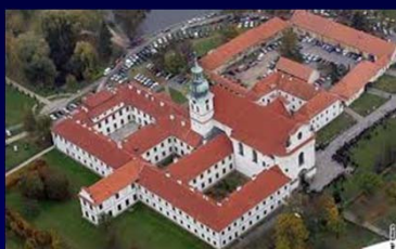
Areál Břevnovského kláštera
