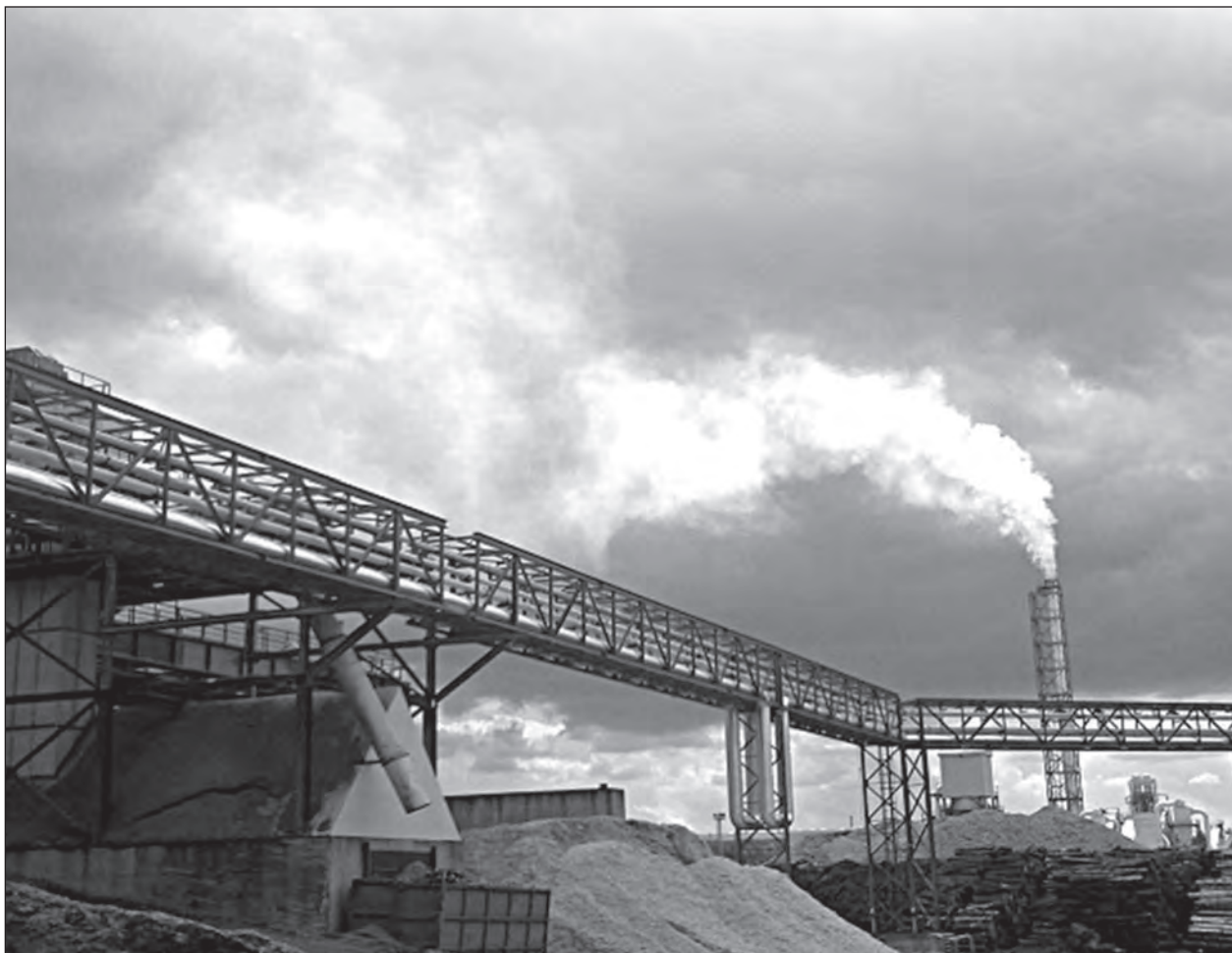
Obr. 5 Charakteristický modrý závoj kouřové vlečky prokazující obsah organických látek v odpadním plynu ze sušárny
