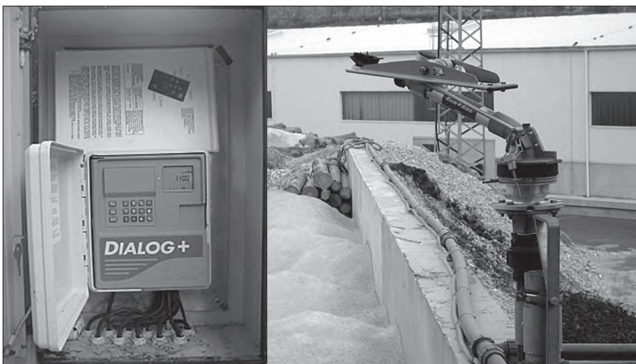
Obr. 3 Systém dálkově ovládaných postřikovacích trysek pro zvlhčování skládek pilin
