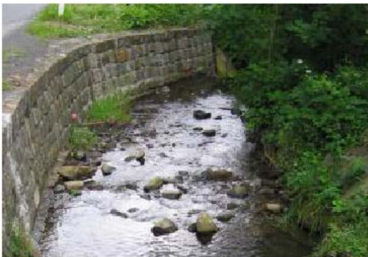
Zpevnění břehu kamennou dlažbou
