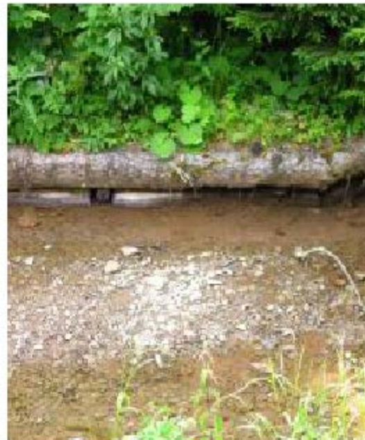
Zpevnění břehu kulatinou
