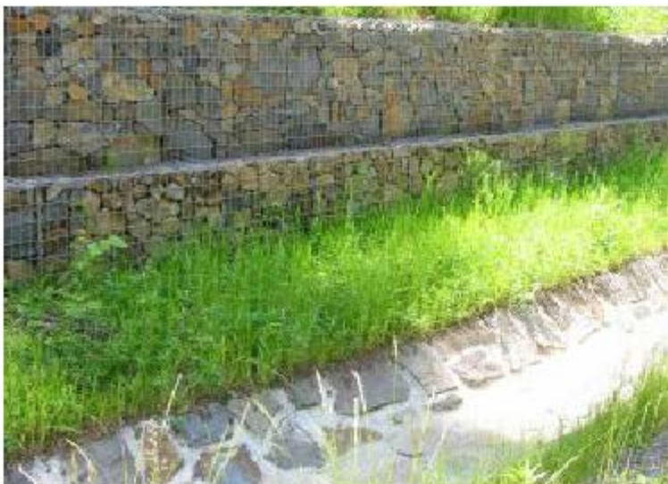
Gabiony na břehu koryta, koryto zpevněno kam. dlažbou
