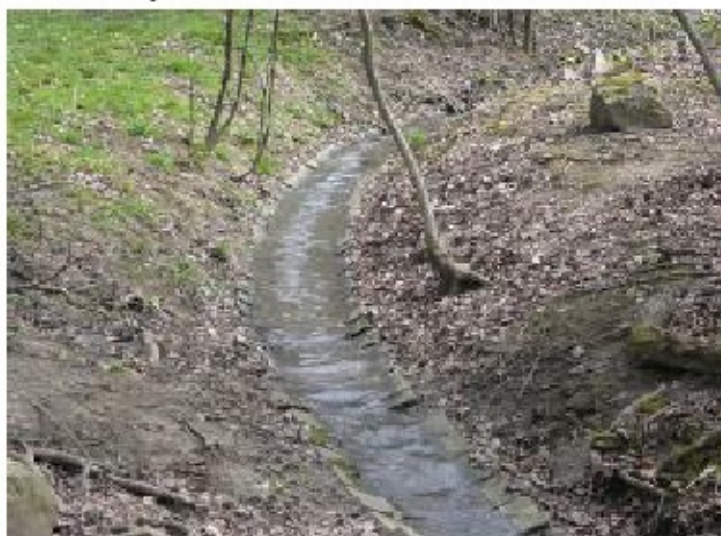
Zpevnění dna betonem – prefabrikované profily
