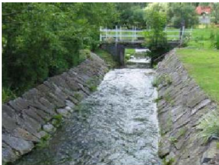
Souvislá úprava dna i břehů kamennou dlažbou
