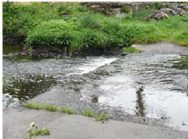
Zpevnění dna betonem – betonové desky
