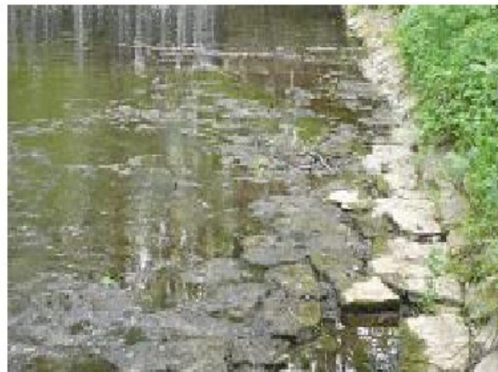
Zpevnění dna kamennou dlažbou.
