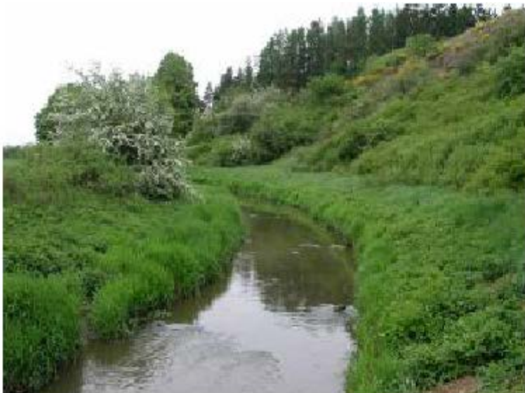
Úprava hrany břehu zatravněním
