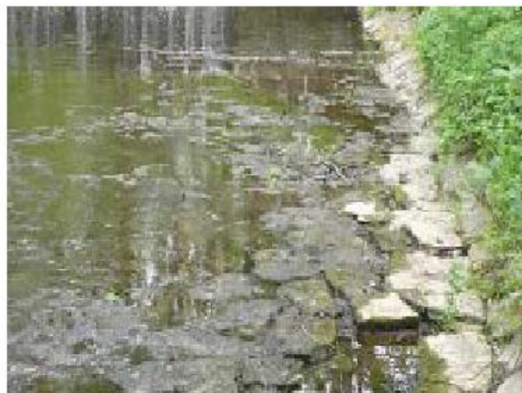
Zpevnění dna kamennou dlažbou.
