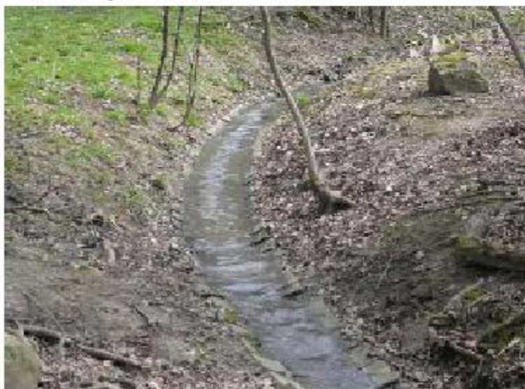
Zpevnění dna betonem – prefabrikované profily
