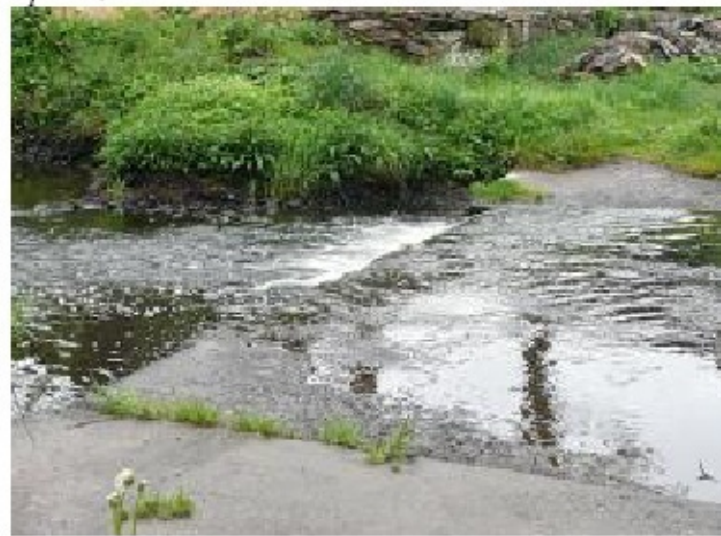
Zpevnění dna betonem – betonové desky
