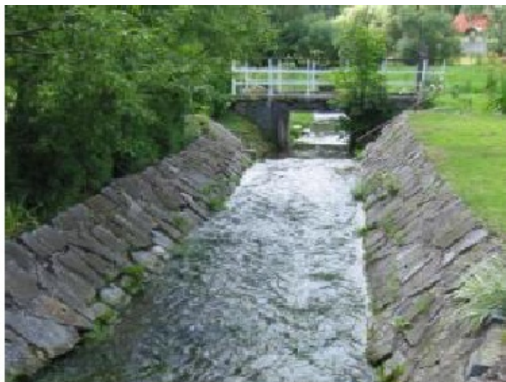
Souvislá úprava dna i břehů kamennou dlažbou
