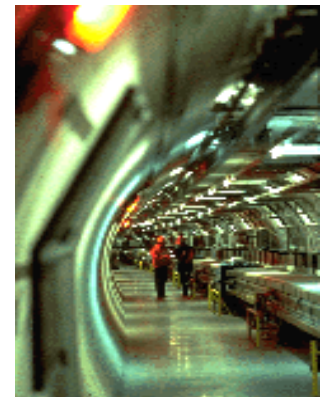
Obr. 42 Největším urychlovačem je LEP (large electron-positron collider), jenž má obvod 27 km a jeho komora je umístěna 100 m pod zemí. Na obrázku je vnitřek komory.
