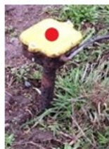
Konec kolejevého obvodu – napájecího či reléového
