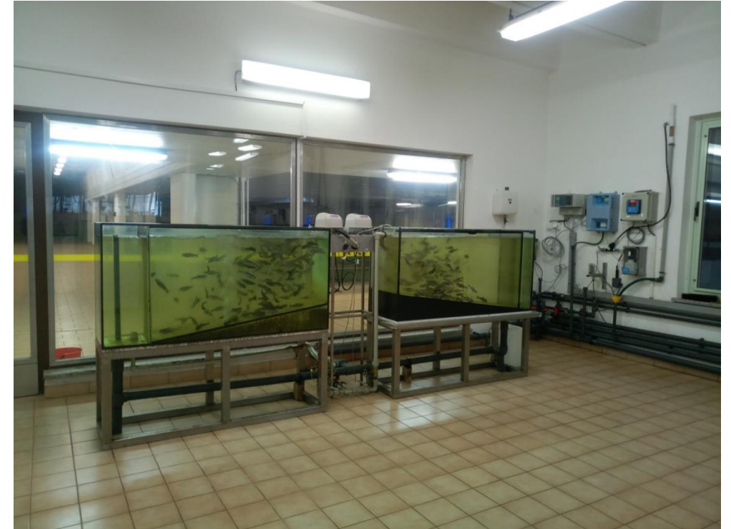
foto: Vítěz, úpravna vody Švařec
