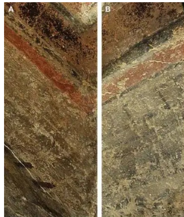
Detail před a po čištění
