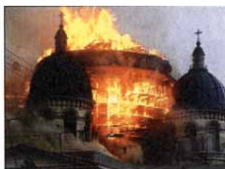
Příčina požáru: neopatrnost při rekonstrukčních pracích.
