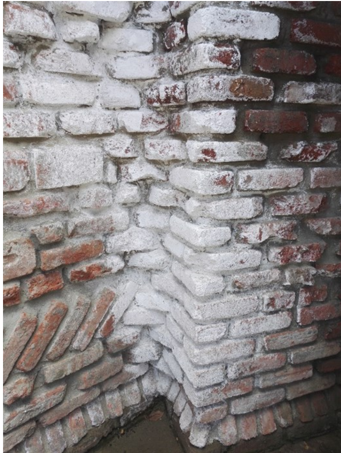
Bílé výkvěty \text{Na}_2\text{SO}_4 na povrchu cihelného zdiva
