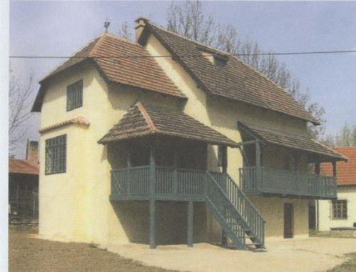
Obr. 137 Při obnově významné solitérní stavby z počátku 20. století byla věnována velká péče záchraně autentických materiálů (tedy i omítek), poškozených zatopením při katastrofální povodni v roce 2002. Vápenné omítky není zapotřebí při podobném poškození paušálně odstraňovat (atelier Zdenky Braunerové v Roztokách u Prahy)
