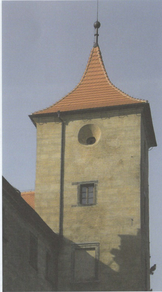
Obr. 139 Příklad citlivého restaurování sgrafitové úpravy renesanční věže, při kterém byl kladen důraz na zachování starobylého vzhledu v kontextu s vizuálním obrazem památky (hrad Grabštejn)
