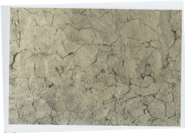
Smršťovací trhliny
