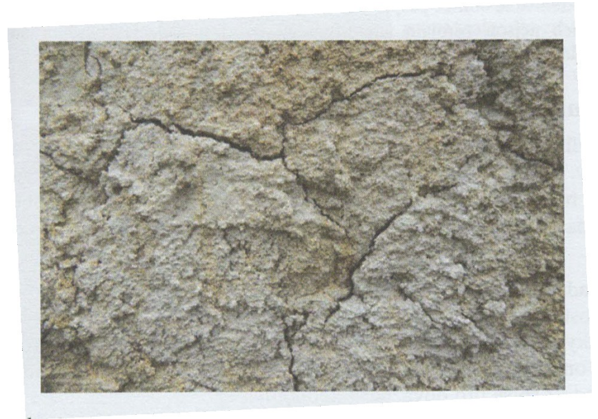
Smršťovací trhliny
