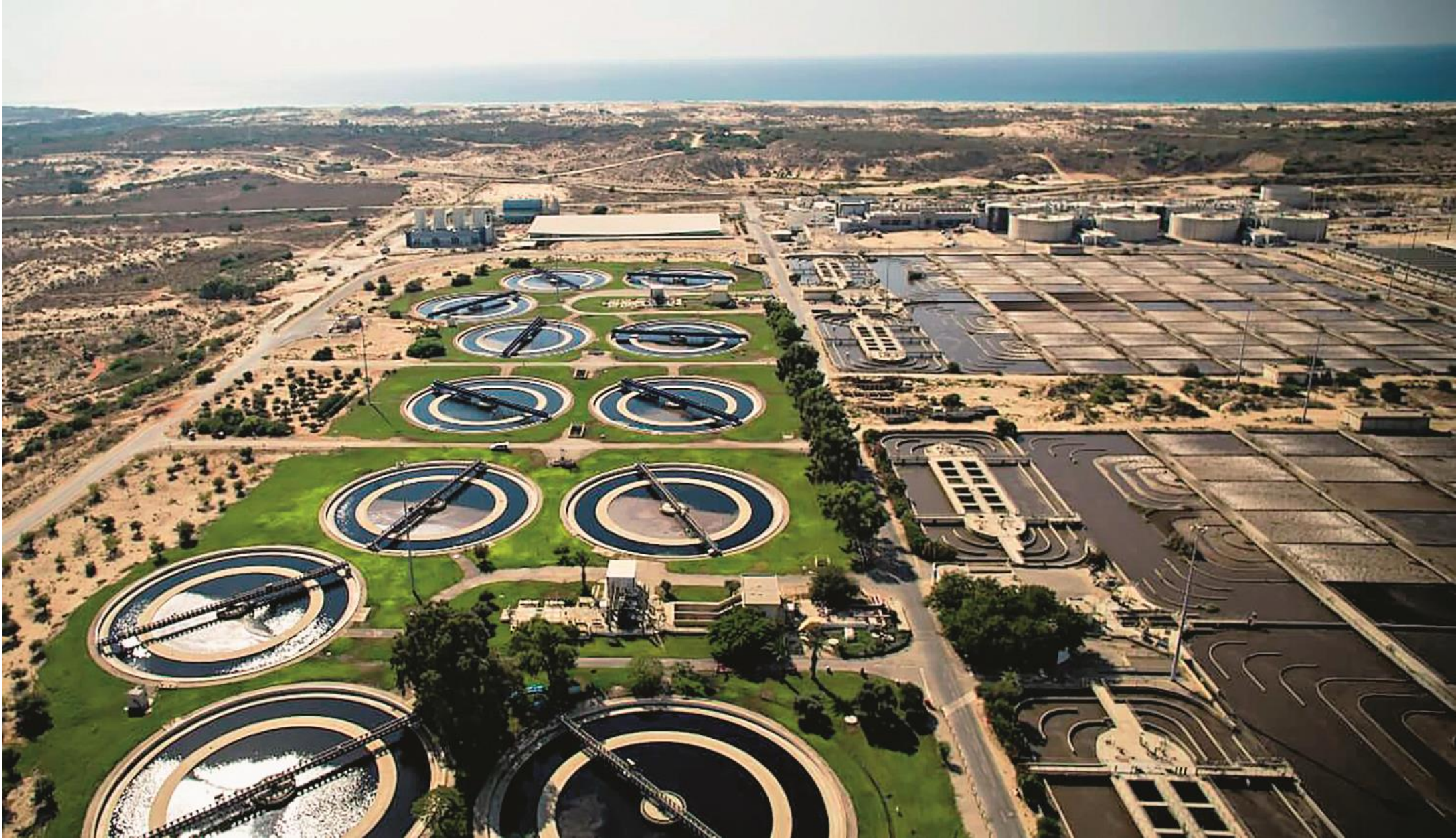
Čistička odpadních vod Šafdan u izraelského města Rišon le-Cijon. Vícestupňové čištění, též přes písečné duny. Izraelci 90 procent recyklované vody znovu používají na závlahy.
