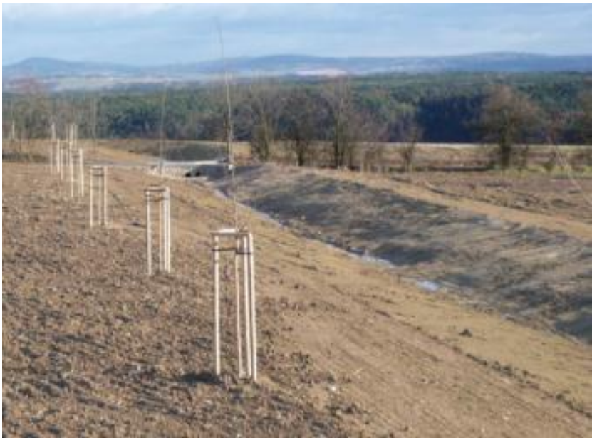
Zasakovací průleh s propustkem
