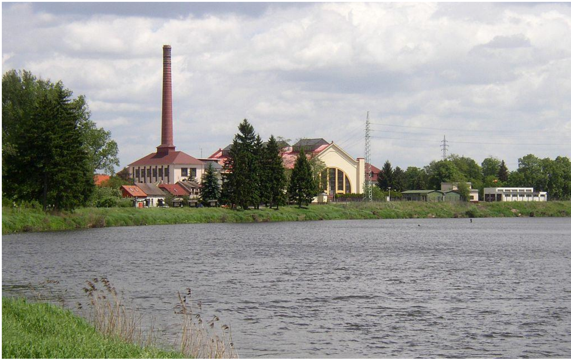
Vodárna Káraný: v provozu od r. 1914, od roku 1968 – umělá infiltrace Do Prahy – 1,5 m 3 /s pitné vody, 3 zdroje vody: břehová infiltrace, umělá infiltrace, artéská voda
