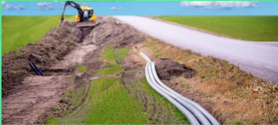
pokládání komunikačního kabelu pod zemí
