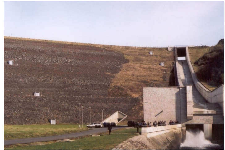
Sypaná přehradní hráz vodní nádrže Slezská Harta – v. 64,8 m, d. 540 m, řeka Moravice, výstavba 1987-1997, zásobování vodou, ochrana povodně
