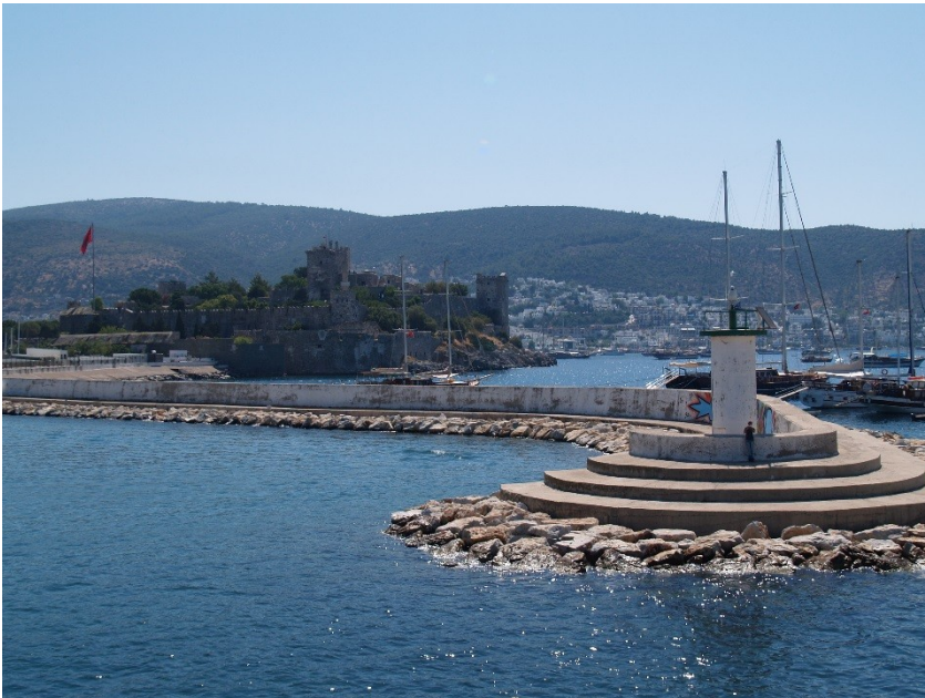
Přístav Bodrum – Turecko – ochranné hráze
