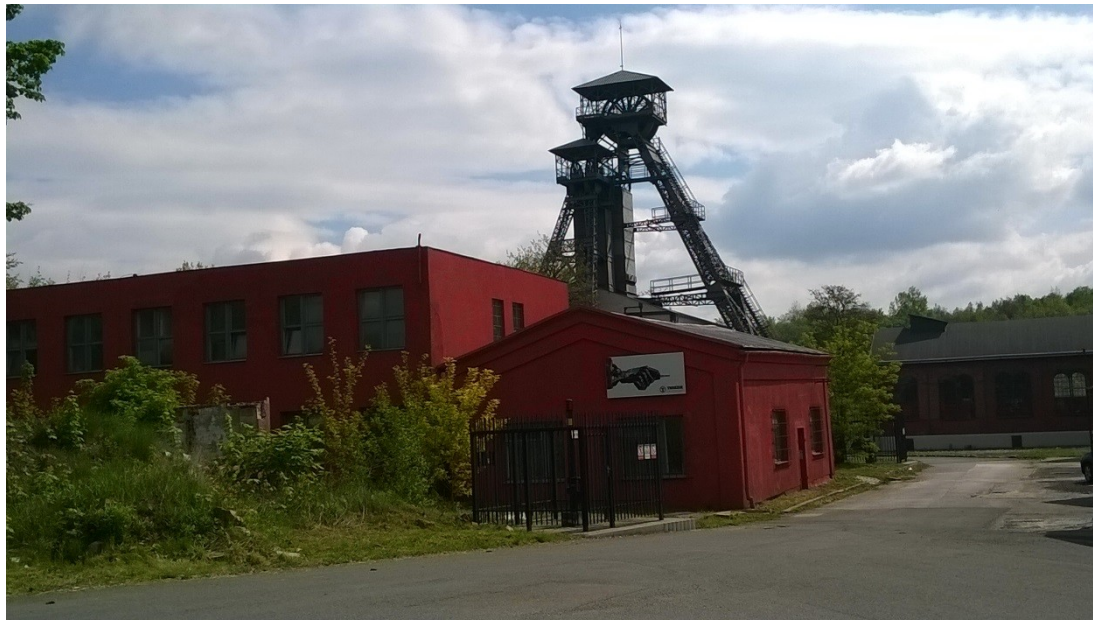
Slezská Ostrava – těžní věž bývalého dolu Petr Bezruč, těžba ukončena 1992, technická památka
