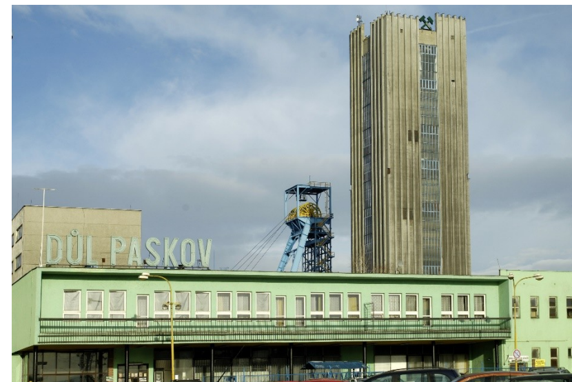
Důl Paskov – lokalita a sídlo Staříč II – těžba ukončena 31.3.2017
