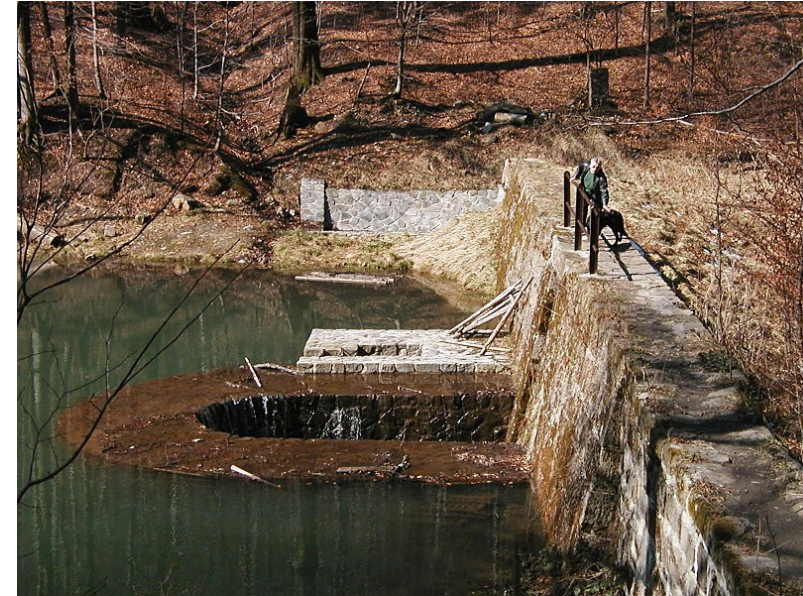
Rajnochovice – Rosošný potok – klauza - rekonstrukce
