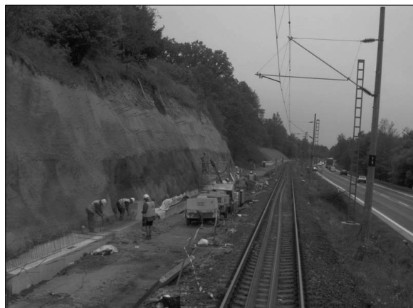
Obr. 8a: Ukázka výstavby opěrné stěny (foto: I. Smolová).
