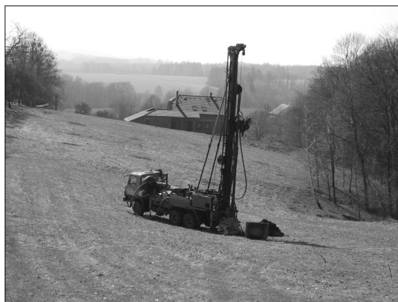
Obr. 18b: Realizace vrtu v Bruzovicích na Frýdecko-Místecku (foto: I. Smolová).
