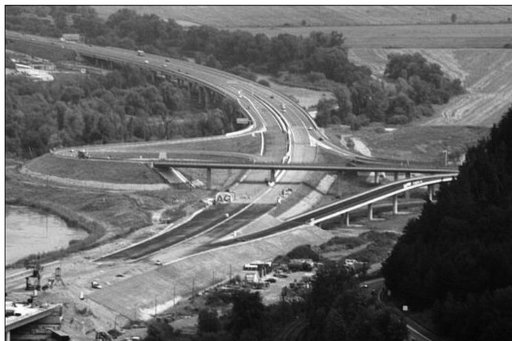
Obr. 58b: Výstavba dálnice D1 na Slovensku v úseku Liptovský Mikuláš–Prešov (foto: I. Smolová).
