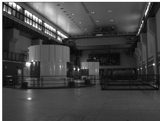
Obr. 36b: Podzemní prostory v. n. Dlouhé Stráně v Hrubém Jeseníku (foto: I. Smolová).
