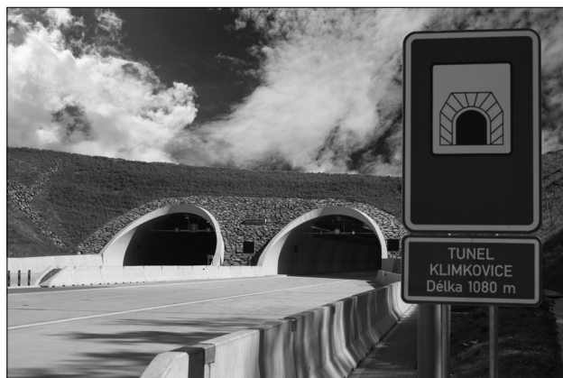
Obr. 56a: Dálniční komunikační tunel u Klimkovic (foto: R. Szczyrba).
