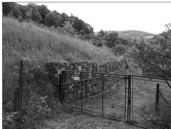
Obr. 8b: Sanace sesuvu stavbou opěrné zdi ve Vsetíně-Jasence (foto: K. Kirchner).
