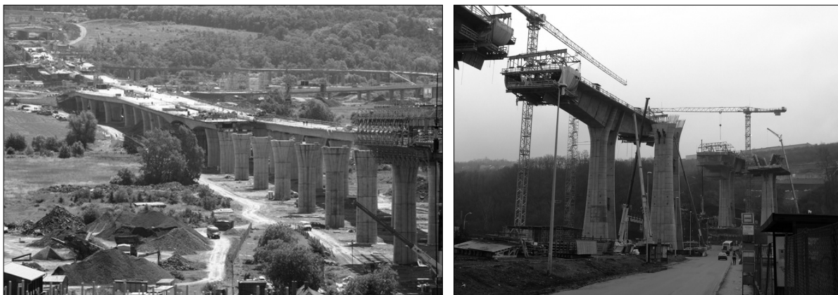
Obr. 61: Výstavba Lahovické estakády přemostující údolí Vltavy a Berounky na jižním okraji Prahy, po dokončení v roce 2010 bude nejdelší mostní konstrukcí v ČR (foto: Ředitelství silnic a dálnic).
