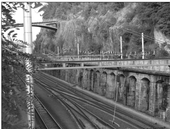
Obr. 57a: Stěny bývalého železničního tunelu v Chocní, které byly vytesány v r. 1845 do tur. slínovců, tunel byl zrušen v letech 1947–1950 (foto: I. Smolová).
