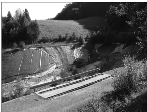
Obr. 46a: Areál připravený pro ukládání odpadu v Olšanech na Šumpersku (foto: I. Smolová).
