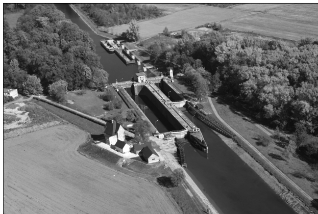
Obr. 77b: Plavební komora Hořín na vodním kanálu Vraňany–Mělník (foto: Povodí Labe, s. p.).
