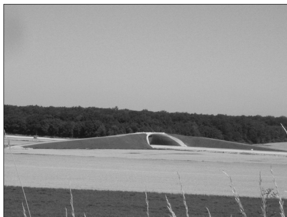
Obr. 53b: Dopravní násyp na Královéhradecku (foto: I. Smolová).
