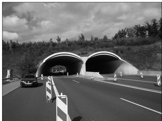
Obr. 59a: Ekodukt Dolní Újezd na dálnici Olomouc–Lipník nad Bečvou (foto: I. Smolová).
