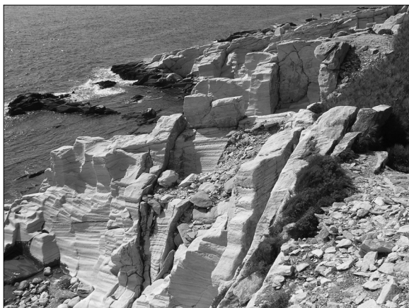
Obr. 7a: Narušení stability svahu při těžbě na pobřeží ostrova Thassos v Řecku (foto K. Kirchner).
