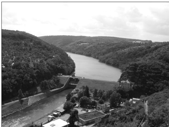
Obr. 64a: Vodní nádrž Znojmo na Dyji (foto: I. Smolová).
