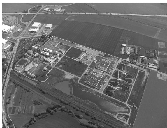
Obr. 85b: Čistírna odpadních vod v Brně-Modřicích (foto: Brněnské vodárny a kanalizace, a. s.).
