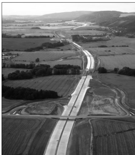
Obr. 58a: Dálnice D47 (foto: I. Smolová).
