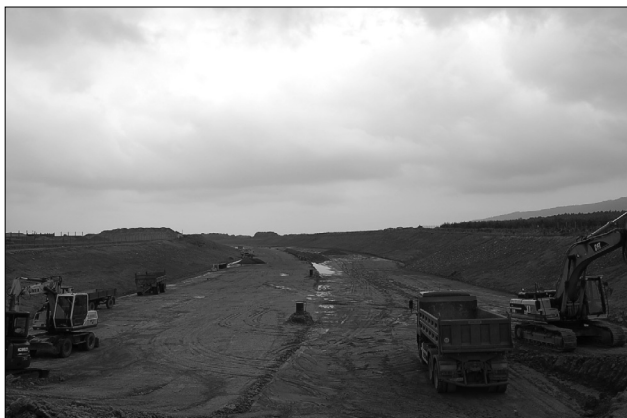
Obr. 54a: Dopravní odkop vznikající při stavbě dálnice D47 (foto: I. Smolová).
