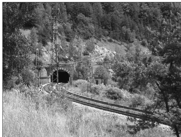
Obr. 57b: Portál železničního tunelu v Pováží (foto: I. Smolová).
