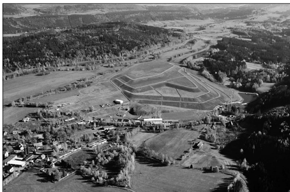
Obr. 31a: Letecký pohled na sanovanou a rekultivovanou haldu v Radvančích v Podkrkonoší (foto: Energie-stavební a báňská, a. s.).
