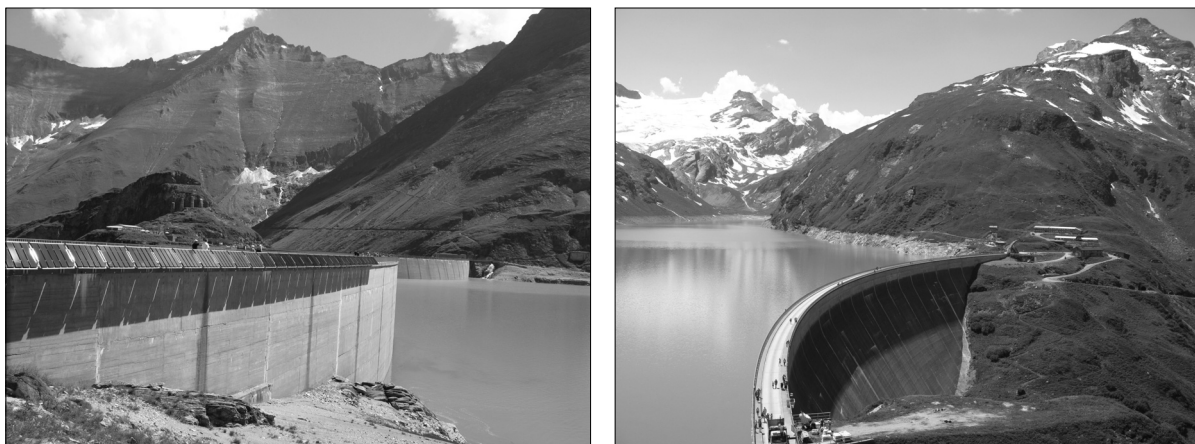
Obr. 68: Vodní nádrž Kaprun (Rakousko) s klenbovou hrází (foto: I. Smolová).
