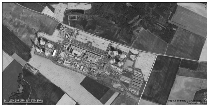
Obr. 33b: Průmyslová plošina jaderné elektrárny Dukovany (letecký snímek) (foto: Geodis Brno, spol. s r. o.).
