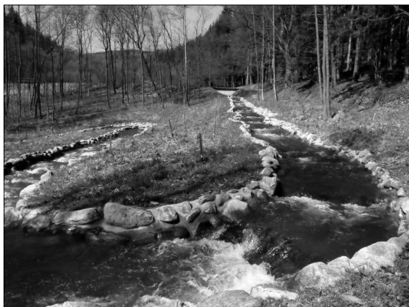
Obr. 81a: Meandrový rybí přechod na Sněžném potoce v Prkenném dole (foto: I. Smolová).
