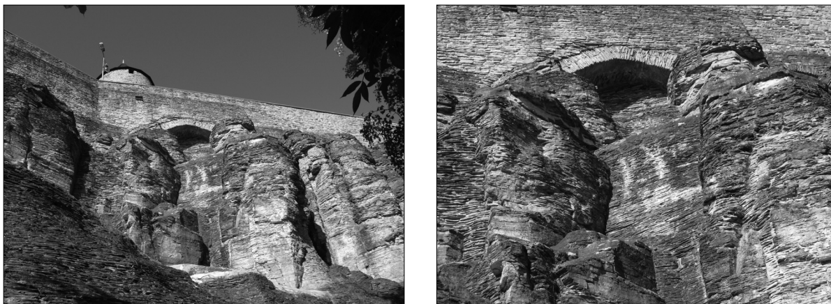
Obr. 9: Ukázka betonové injektáže skalních stěn tvořených turonskými slínovci (opukou) v Novém Městě nad Metují (foto: I. Smolová).
