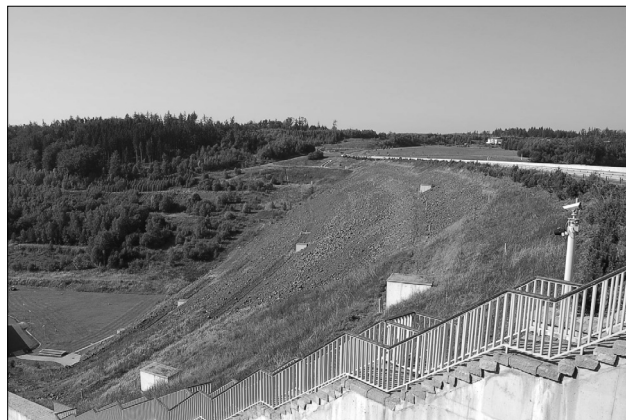
Obr. 64b: Hráz vodní nádrže Slezská Harta na Moravici (foto: I. Smolová).
