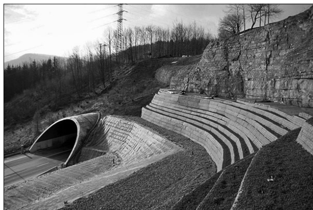
Obr. 4b: Sanovaný sesuv u silničního tunelu Hřebeč (foto: I. Smolová).
