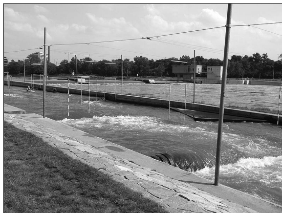
Obr. 71b: Umělý kanál Čertovka na Malé Straně (foto: I. Smolová).
