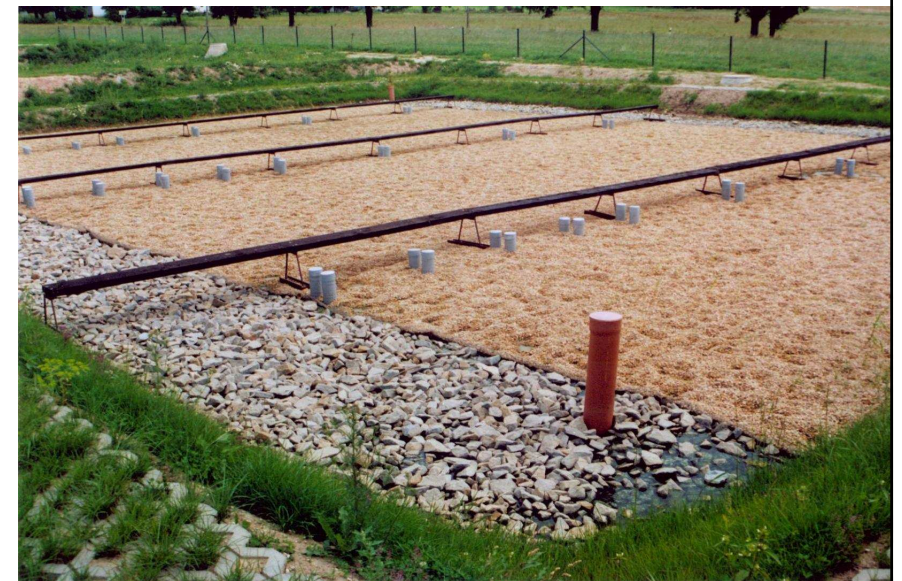
Schéma kořenové čistírny odpadních vod
