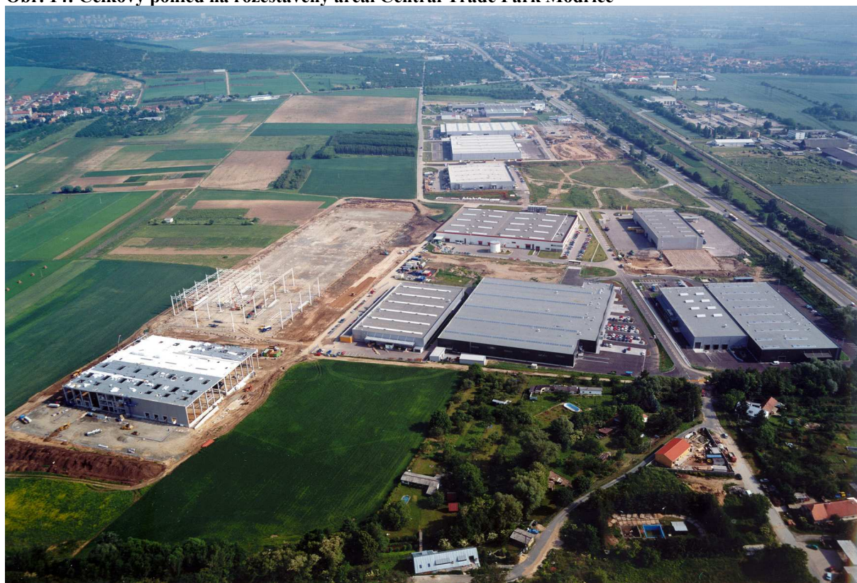
Obr. 14: Celkový pohled na rozestavěný areál Central Trade Park Modřice
