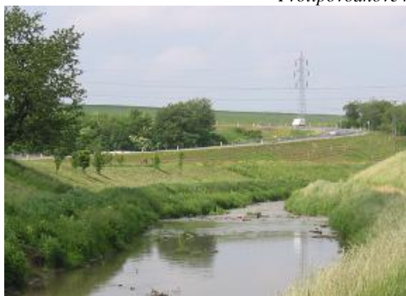
Liniové stavby vedené paralelně s korytem – násyp silnice
