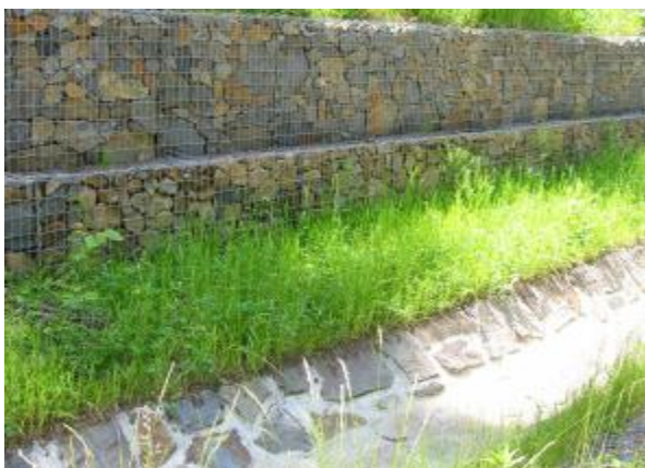
Gabiony na břehu koryta, koryto zpevněno kam.dlažbou
