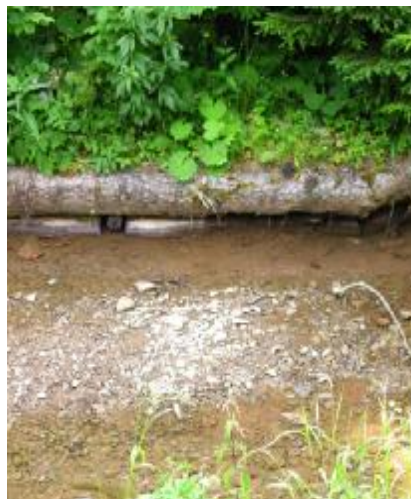
Zpevnění břehu kulatinou
