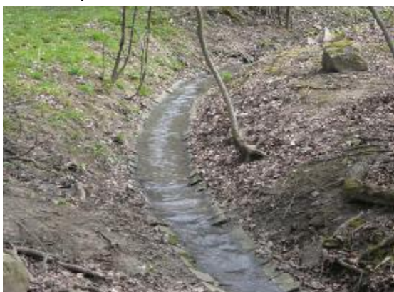
Zpevnění dna betonem – prefabrikované profily
