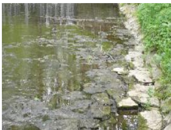
Zpevnění dna kamennou dlažbou.
