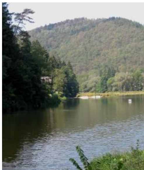
Vzdutí nad jezem
