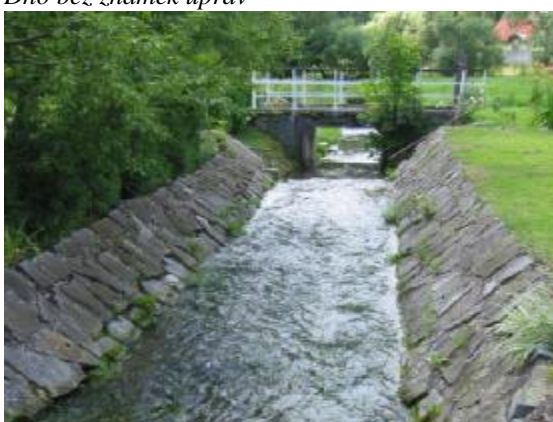
Souvislá úprava dna i břehů kamennou dlažbou
