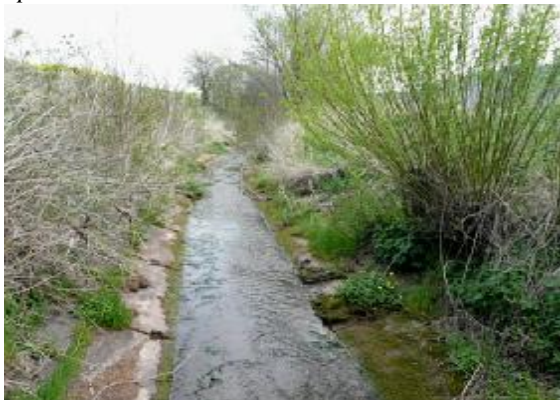
Souvislá úprava profilu - zpevnění břehu i dna betonovými deskami (vlevo), kam.dlažbou (vpravo)
