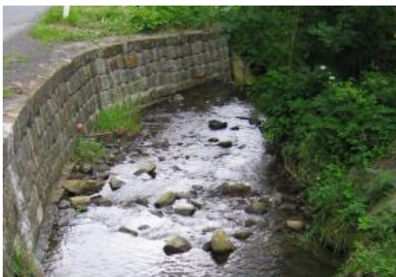
Zpevnění břehu kamennou dlažbou
