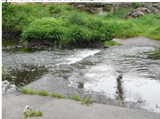
Zpevnění dna betonem – betonové desky
