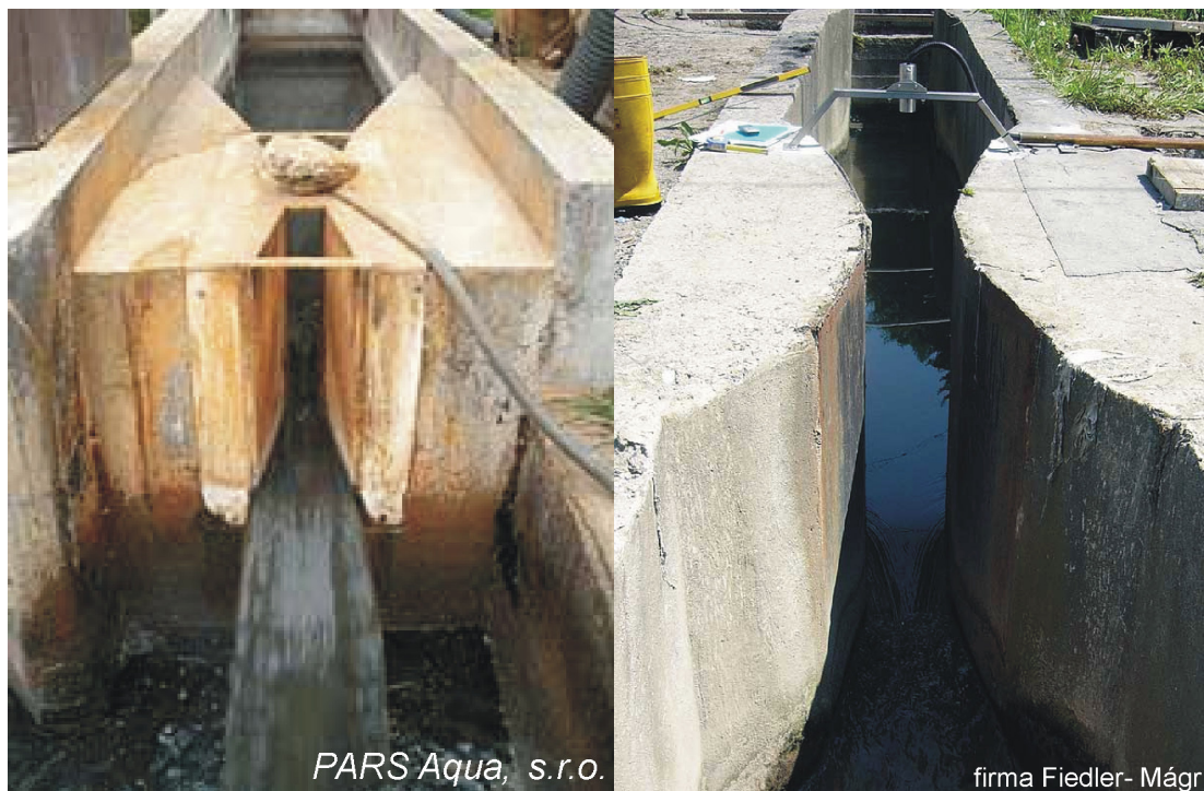
Obr. 3 Parshallův (vlevo) a Venturiho (vpravo) měrný žlab
