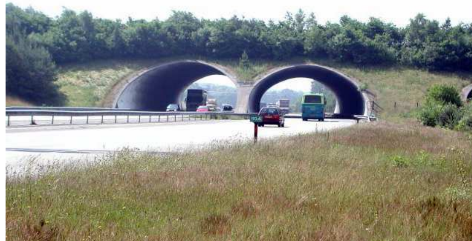
Nadchod pro zvěř na dálnici v Nizozemsku
