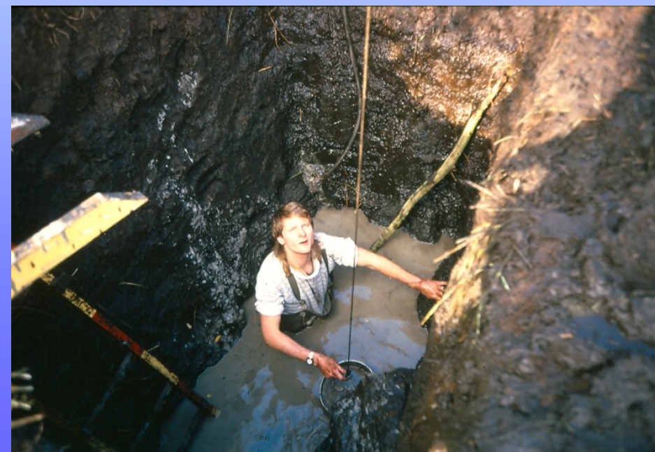
Švarcenberk (Třeboňsko) - výkop
