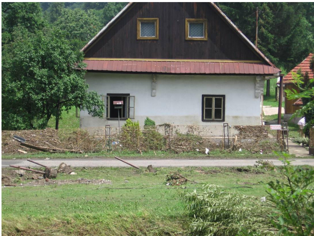
Foto 3.5 – Jeden z objektů v obci Bludovice v dosahu záplavy s liniovou stopou po maximální hladině.
