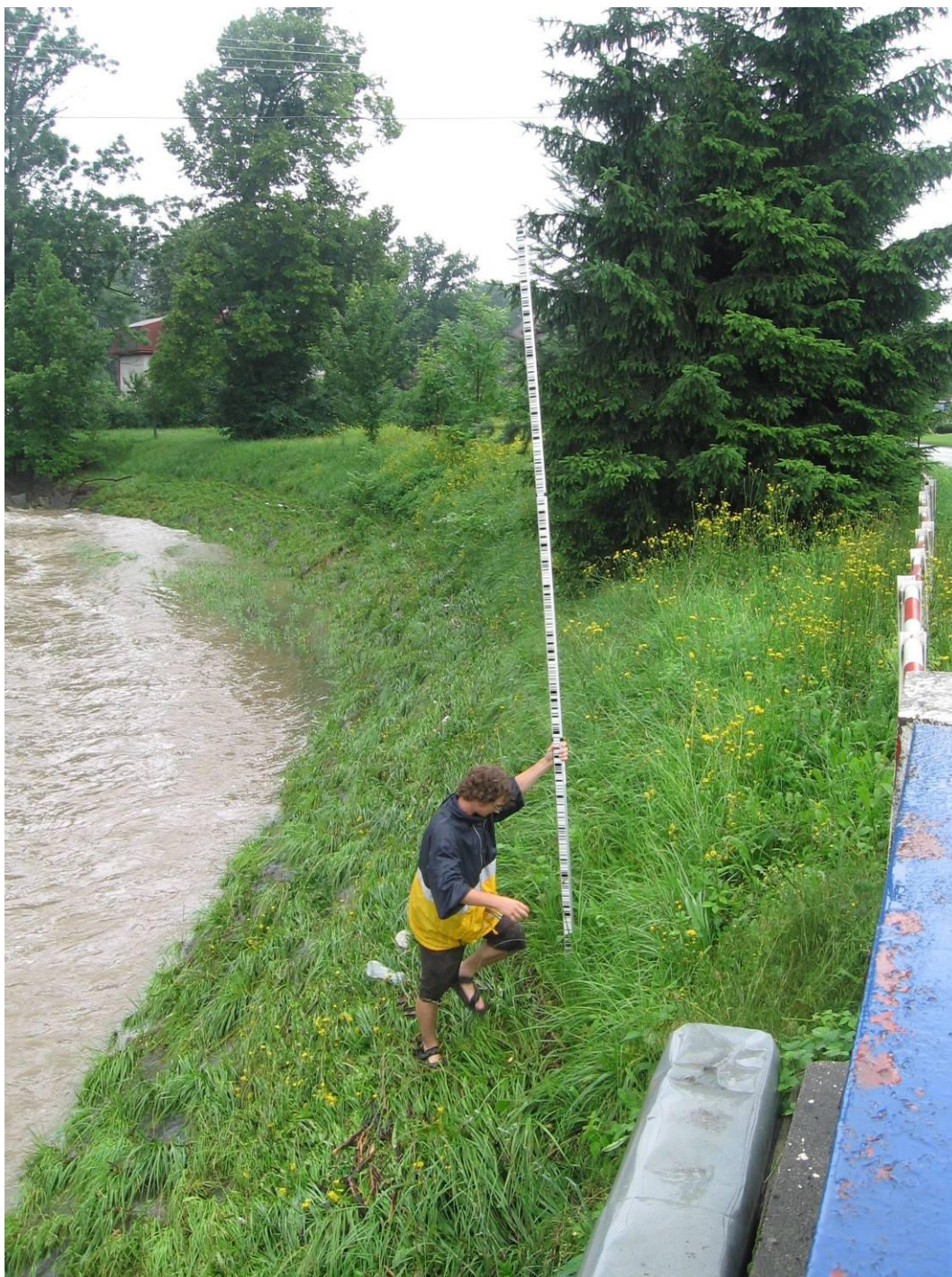
Foto 3.25 – Upravené koryto Sedlnice nad hlavním silničním mostem v Sedlnici s patrnou stopou ulehlé trávy po průchodu povodně
