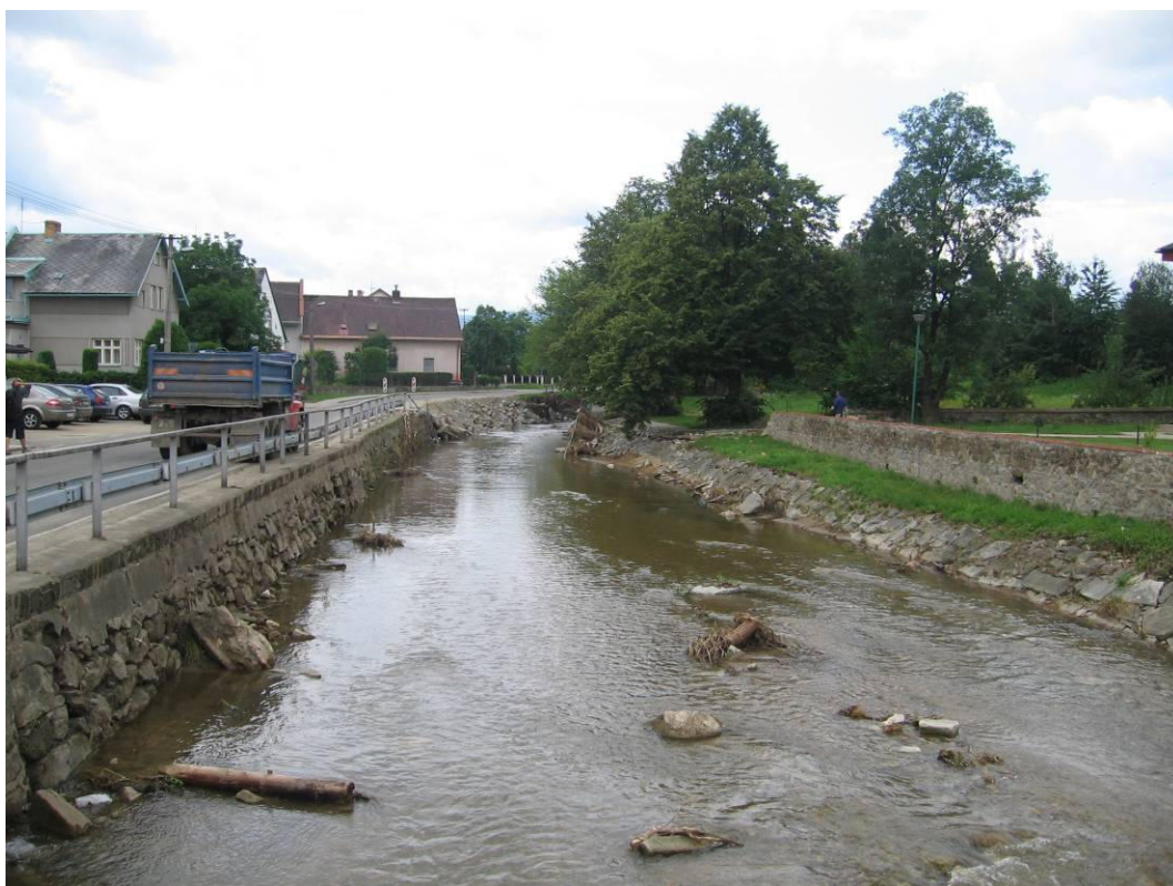
Foto 4.9 – Vojtovický potok na hlavním silničním mostem v Bernarticích
