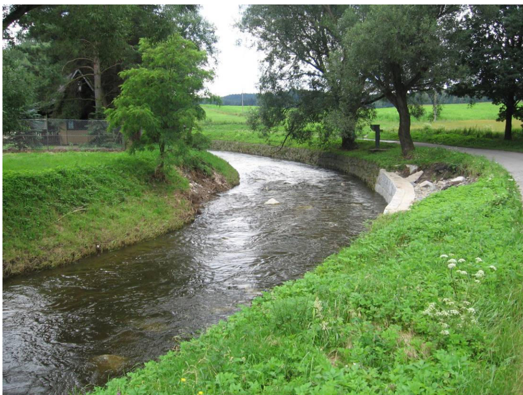
Foto 4.11 – Upravené koryto Černého potoka pod profilem limnigrafické stanice Velká Kraš
