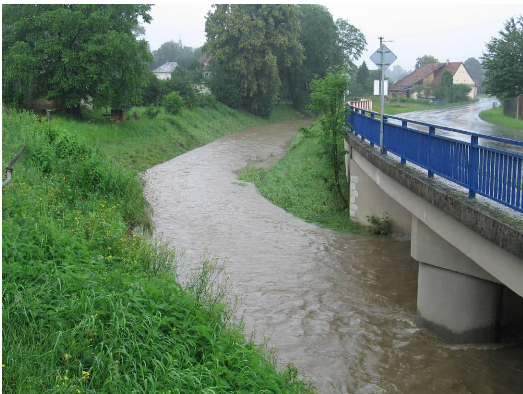
Foto 3.26 – Upravené koryto Sedlnice pod hlavním silničním mostem v Sedlnici s patrnou stopou ulehle trávky po průchodu povodně
