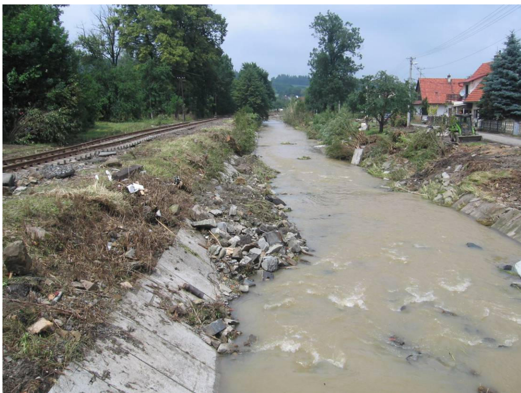
Foto 3.4 – Přímý úsek Zrzávky v Bludovicích po povodni s důsledky chodu splavenin
