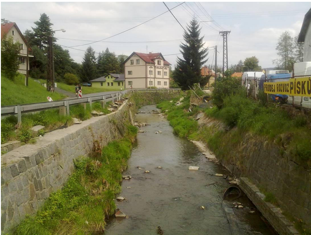
Foto 5.2 – Koryto Bystré na konci horního úseku měrné tratě v Benešově nad Ploučnicí
