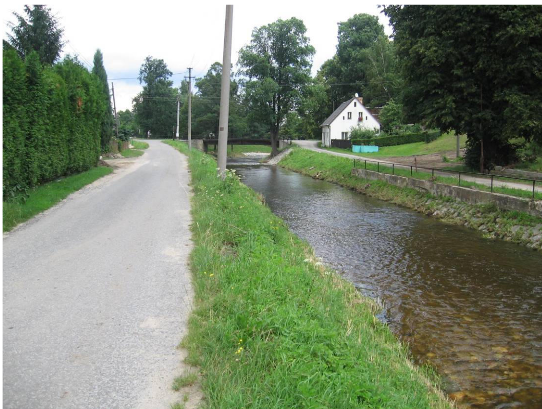
Foto 4.12 – Upravené koryto Černého potoka nad soutokem s Vidnávkou
