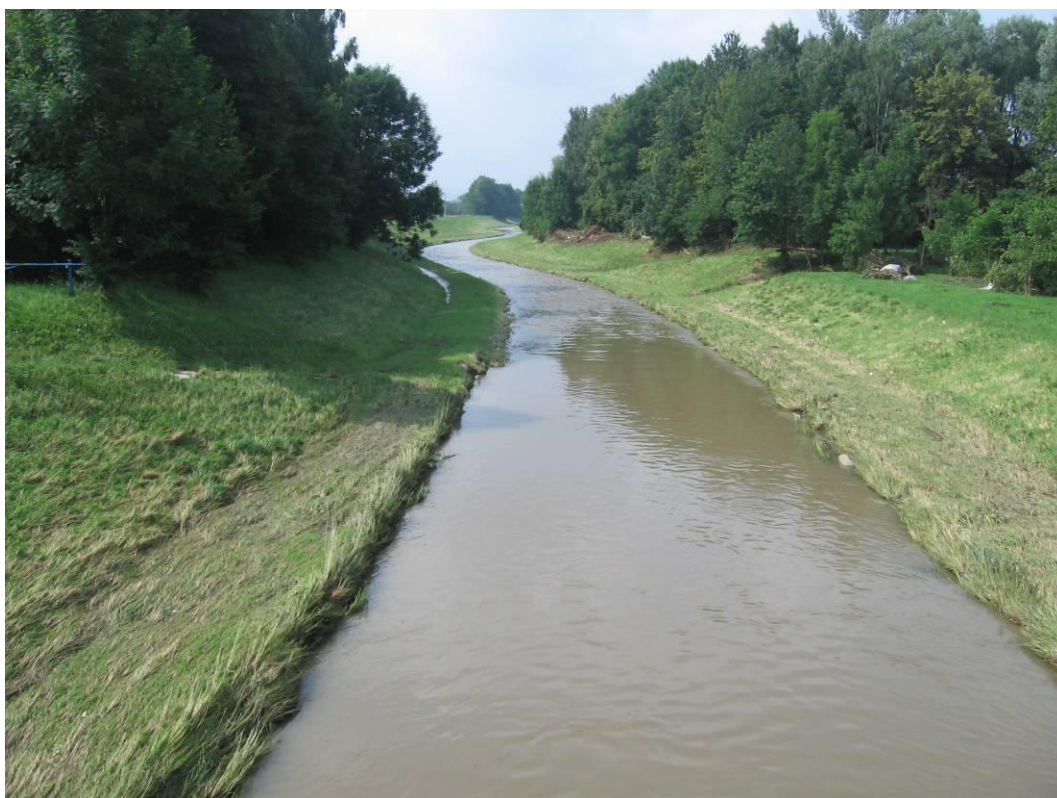
Foto 3.11 – Zcela nepoškozené koryto Jičínky v Kuníně na převážné délce řešeného úseku
