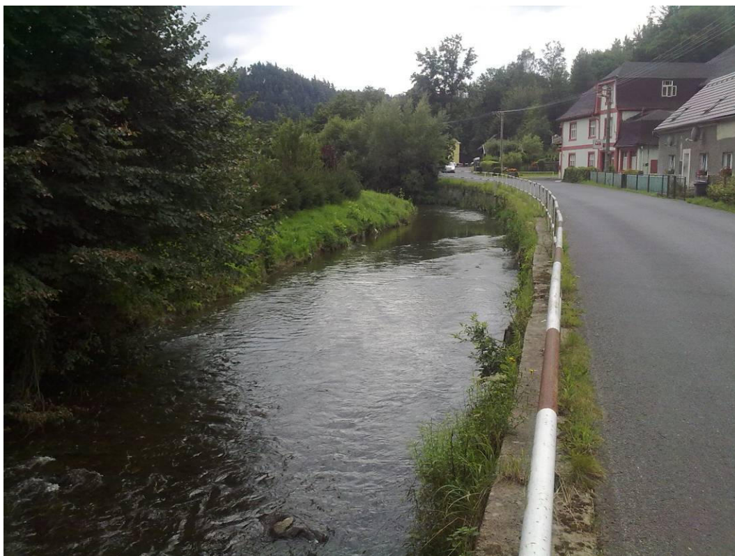
Foto 5.7 – Úsek měrné tratě na Kamenici v Srbské kamenici vedoucí podél silnice
