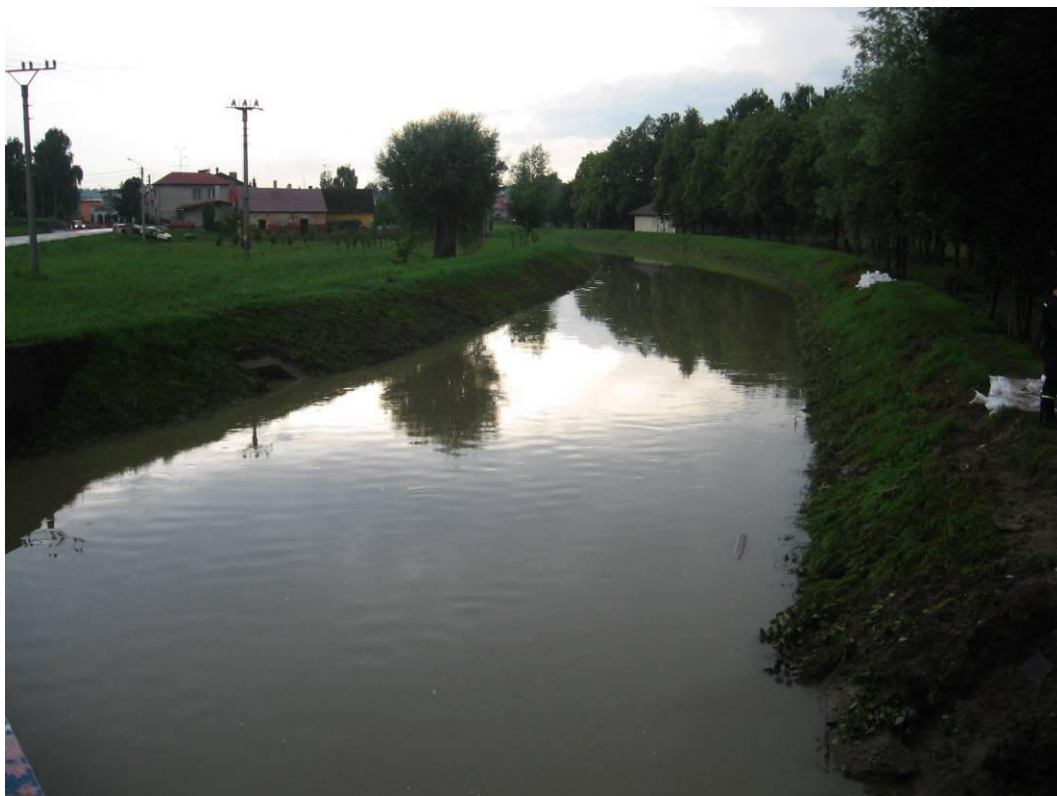
Foto 3.16 – Upravené koryto Luhy v Jeseníku nad Odrou bez patrného poškození povodní
