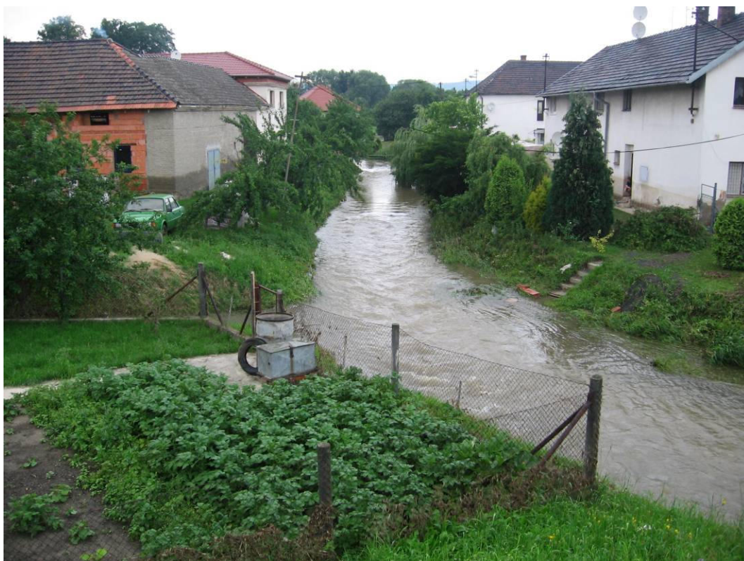
Foto 3.14 – Koryto Luhy nad silničním mostem s patrnými stopami po hladině na stavbách
