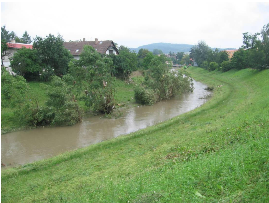
Foto 3.6 – Koryto Jičínky po povodni v Novém Jičíně v úseku mezi limnigrafickou stanicí a lávkou
