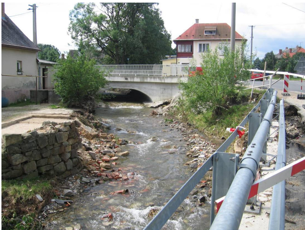
Foto 4.3 – Koryto Skorošického potoka pod silničním mostem
