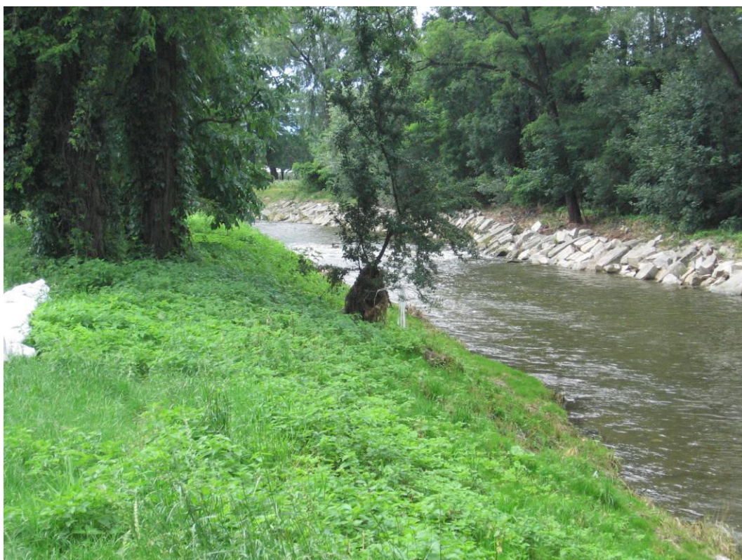
Foto 4.14 – Upravené koryto Vidnávky na dolním konci měrné tratě pod silničním mostem
