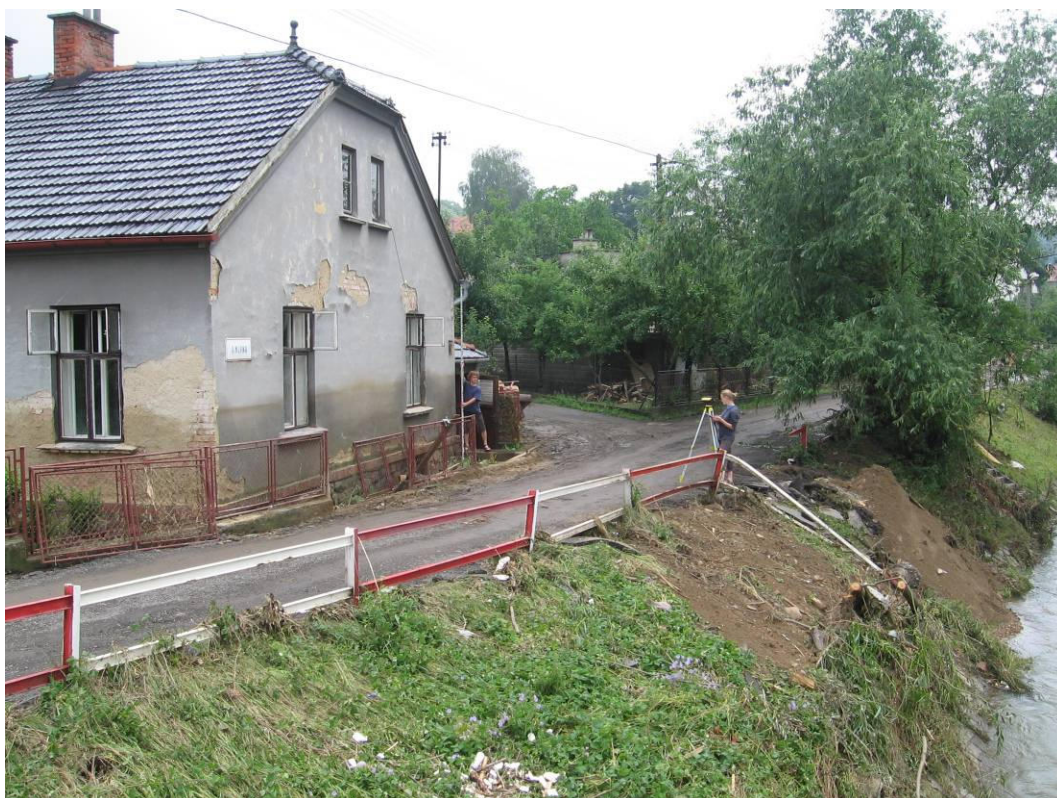
Foto 3.2 – Zaměření stopy po kulminační hladině na objektu nad hlavním silničním mostem.
