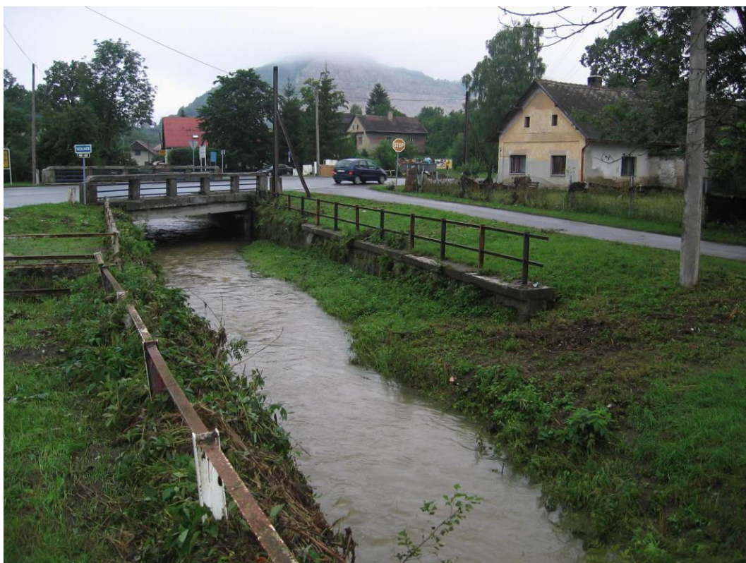
Foto 3.23 – Koryto Sedlnice nad hlavním silničním mostem v Ženklavě
