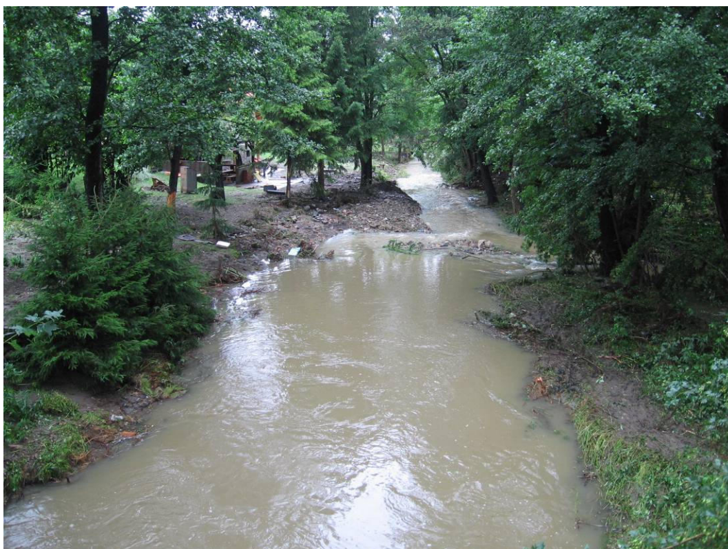
Foto 3.22 – Koryto Sedlnice ve střední části řešeného úseku v obci Ženklava
