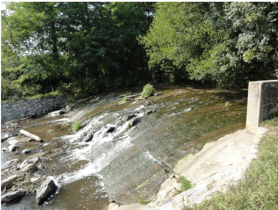
Foto. 7. Technicko-inženýrská úprava na toku v podobě betonového jezu před Veverskou Bítýškou
