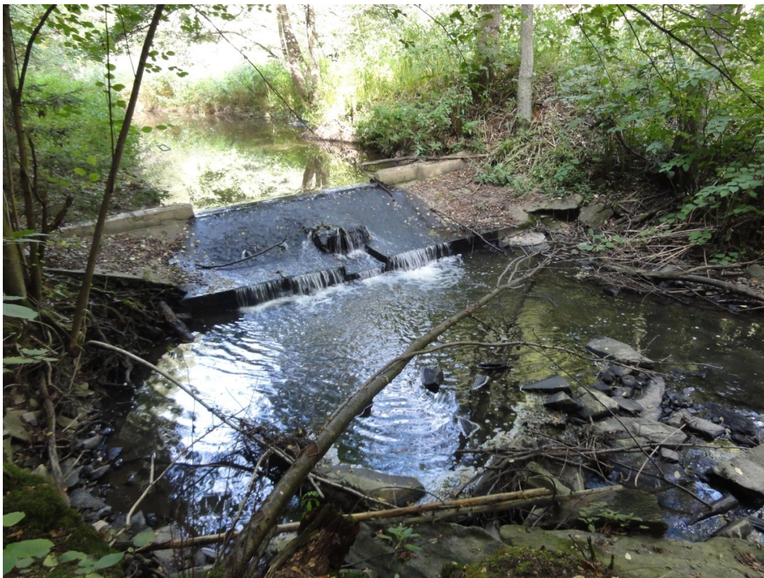
Foto. 2. Technicko-inženýrská úprava na toku v podobě betonového jezu za Ryglůvským mlýnem
