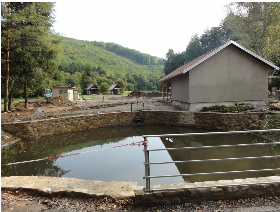
Foto. 4. Vodohospodářská úprava akumulárního (průtočného) charakteru na bývalém mlýnském náhonu Hálův mlýn
