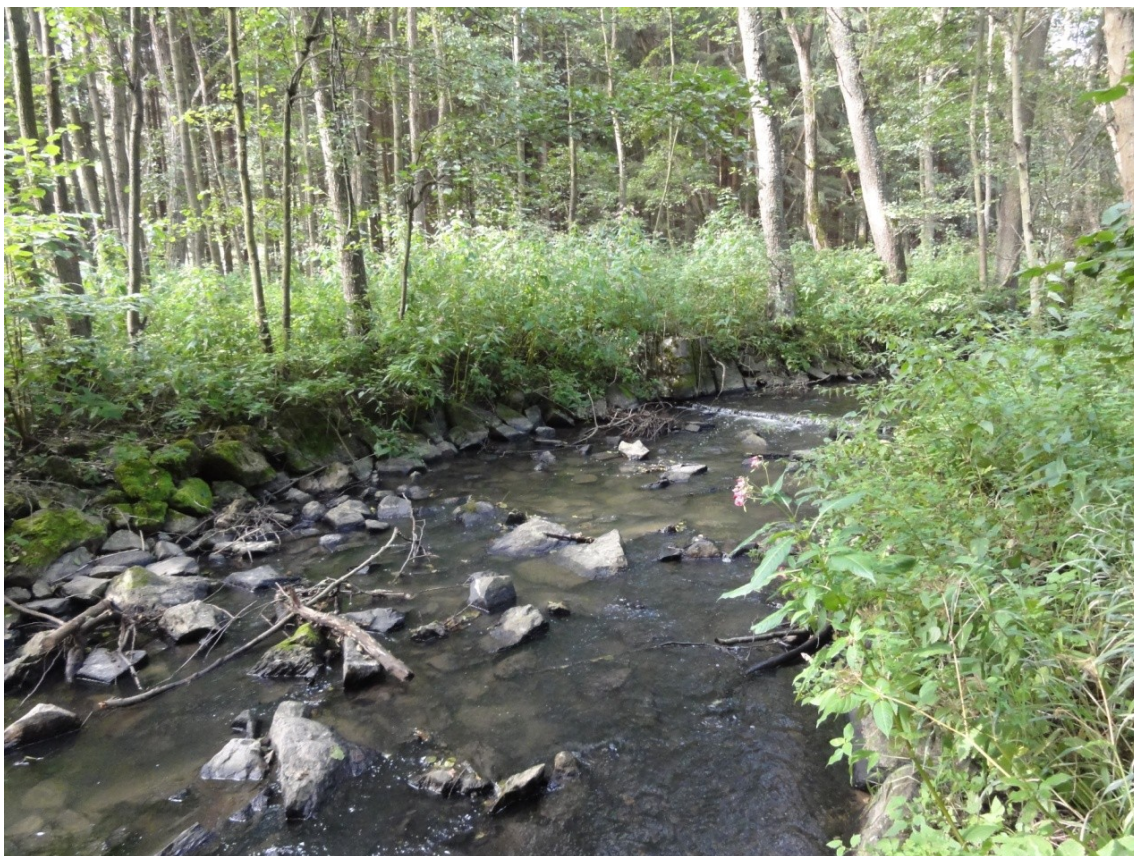
Foto. 5. Zpevnění břehů toku v podobě kameninového záhozu u Rygllovského mlýna
