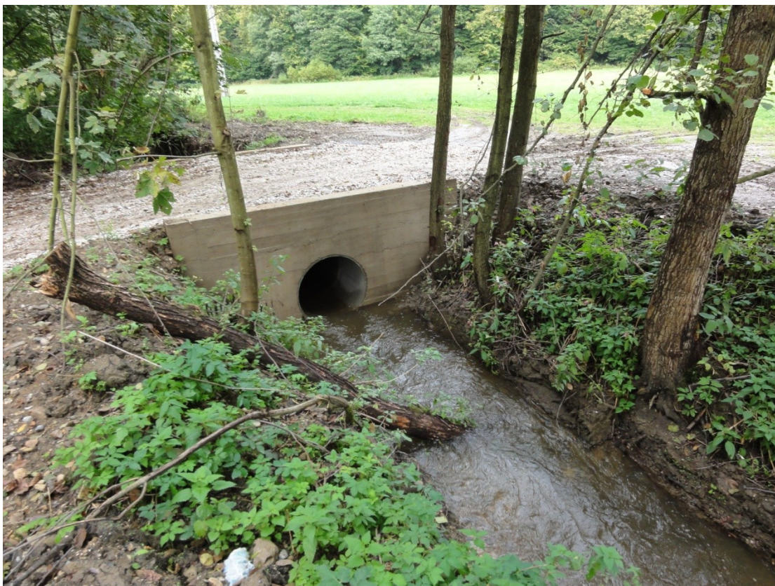
Foto. 3. Technicko-inženýrská úprava na toku v podobě mostní konstrukce s umělým korytem před obcí Šmelcovnou
