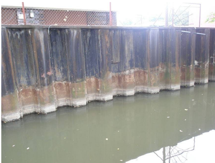
Obr. 11: Opevnění břehu v podobě štětové stěny, v části Trnítá.
