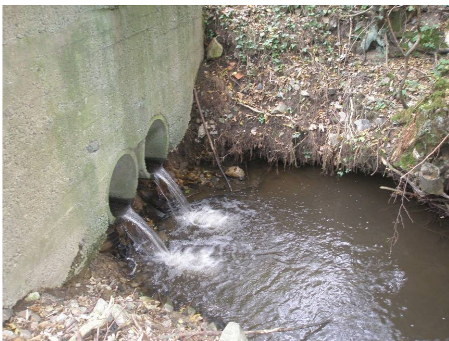
Obr. 14: Propustek v přirozené části toku mezi Vranovem a Lelekovicemi.
