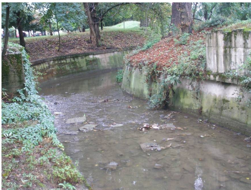
Obr. 10: Betonové opevnění břehů v části Brno-Komárov.
