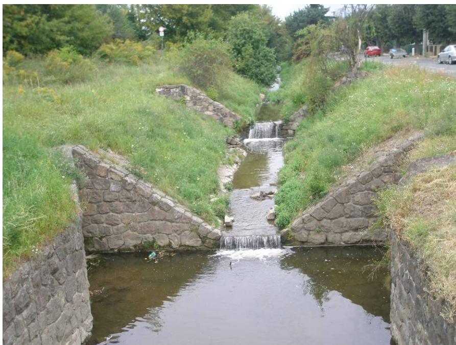
Obr. 13: Série stupňů na opevněném napřímeném toku v Králově Poli.
