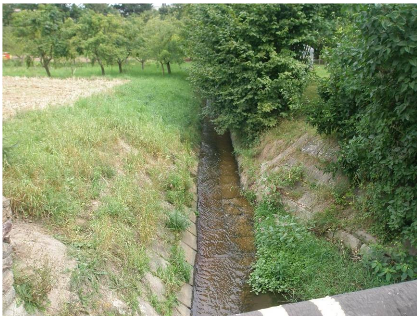
Obr. 12: Napříměný a kompletně opevněný úsek kamennou dlažbou v Lelekovicích.
