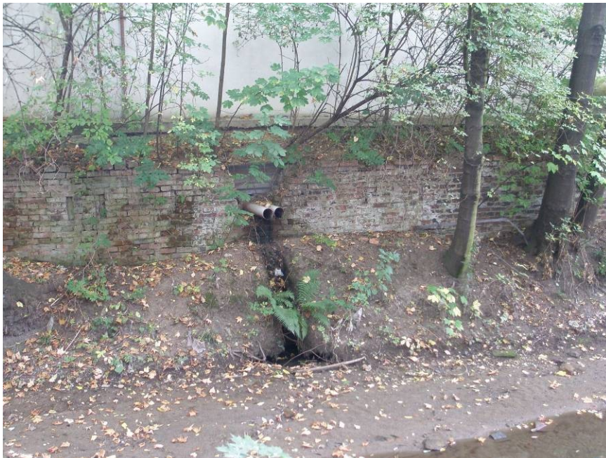
Obr. 23: Vyústění potrubí do koryta.
