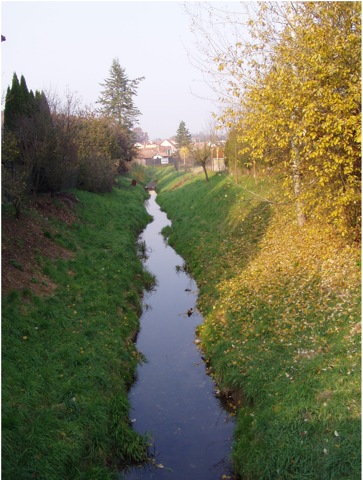
Foto 17: Napřimené a zkapacitněné koryto v Chudčicích s drobnými erodujícími nátržemi
