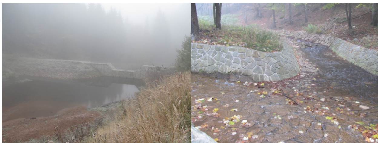
Obr. 14: Vlevo jedna z protipovodňových nádrží na Bystřici pod Kutným vrchem, vpravo ukázka zpevněného koryta i břehu na příkladu soutoku Bystřice s Liščím potokem.
