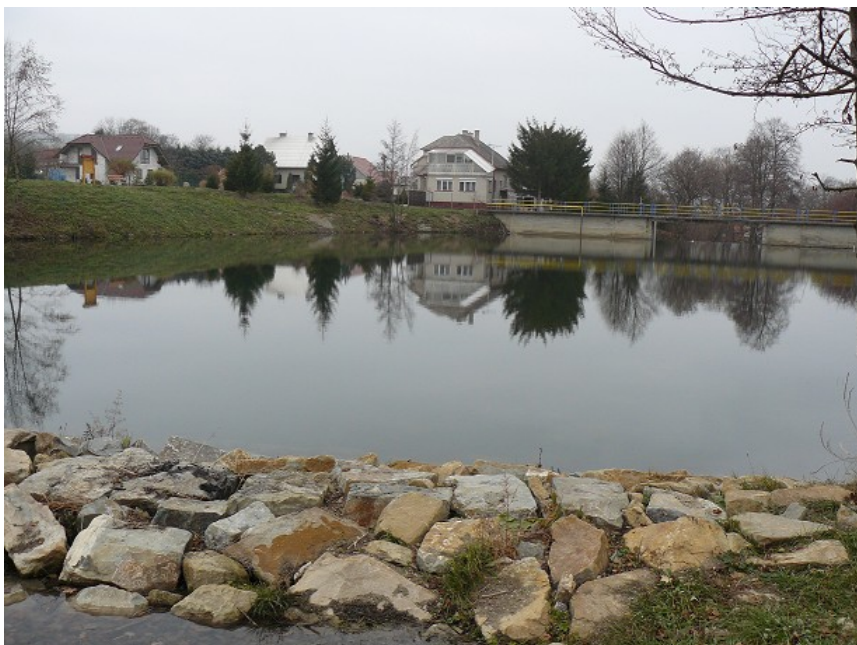
Obr. 17. Protipovodňová hráz s rybníkem u obce Horní Němčí v horní části toku
