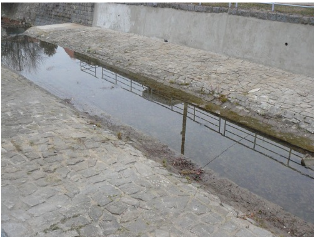
Obr. 12. Oboustranné betonové opevnění břehů s postranními stěnami a zábradlím a zkapacitněným korytem v obci Dolní Němčí
