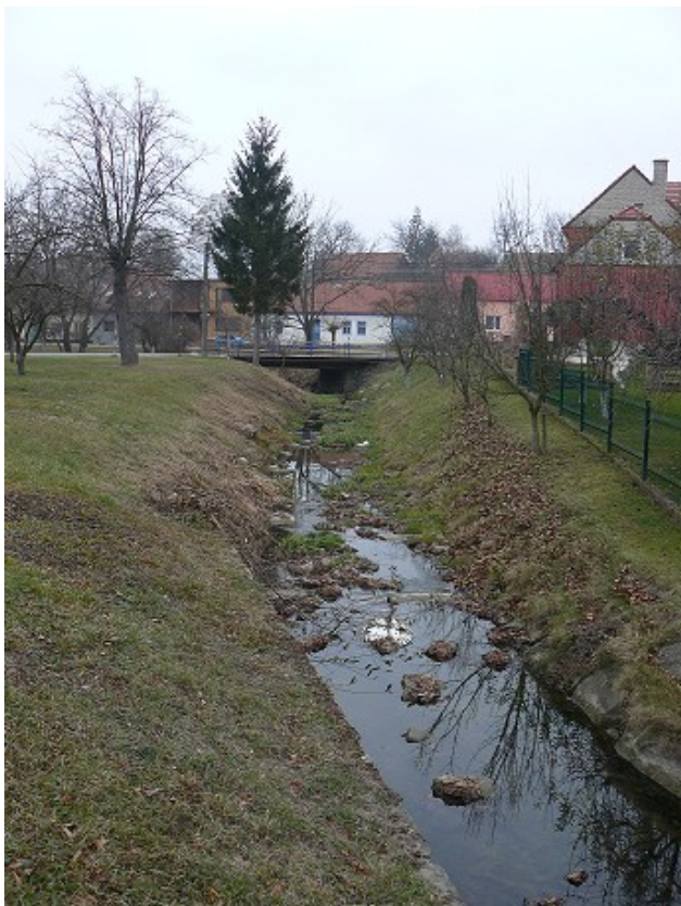
Obr. 10. Zkapacitněné koryto říčky Okluky v obci Horní Němčí (horní tok)
