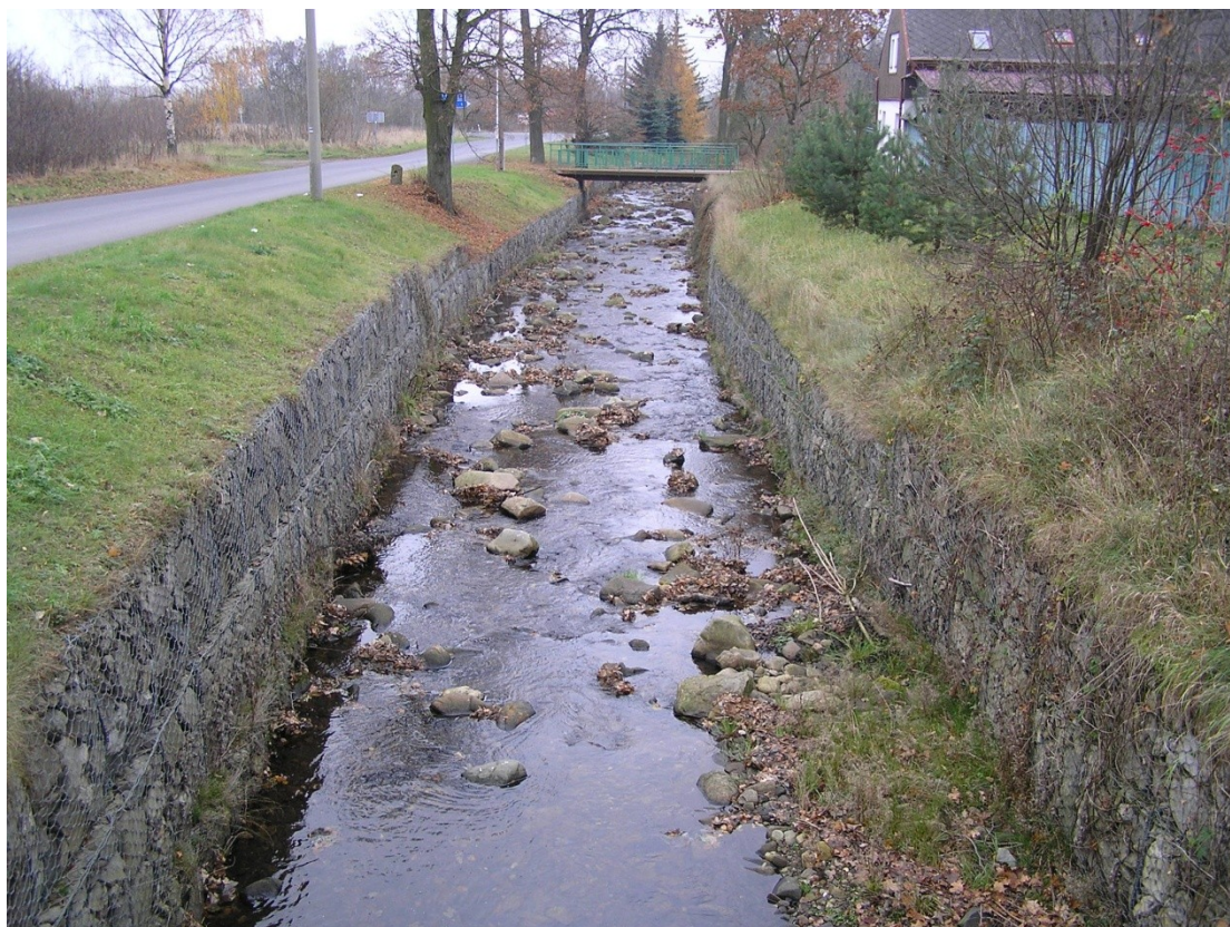
Foto 9: Zpevnění břehů potoka v Nové Vísce.
