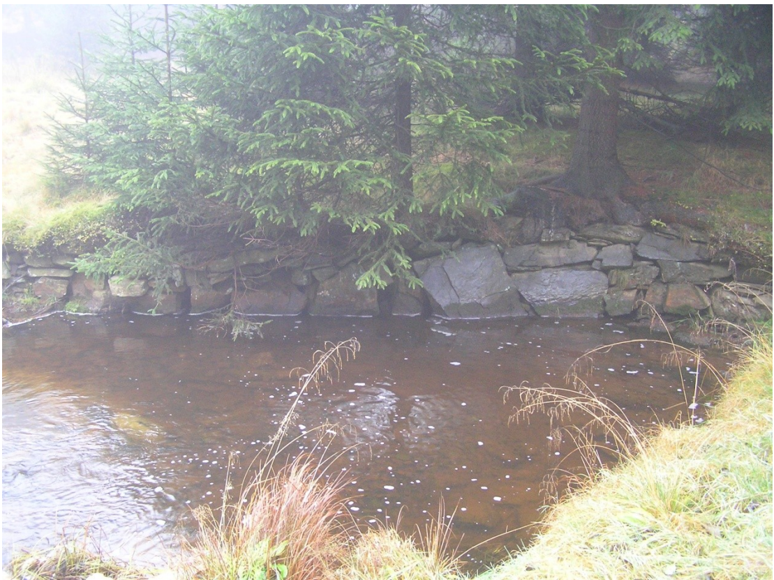
Foto 4: Zpevnění břehů kameny ve 2. úseku.
