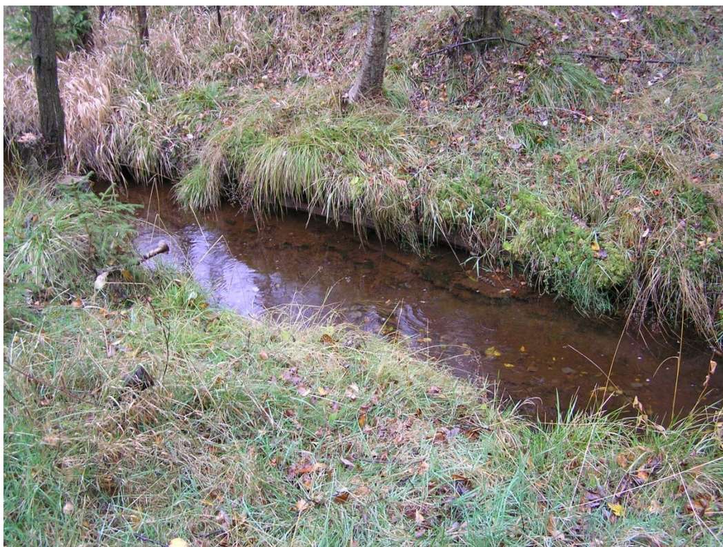
Foto 1: Zpevnění břehů toku v 1. úseku potoka.
