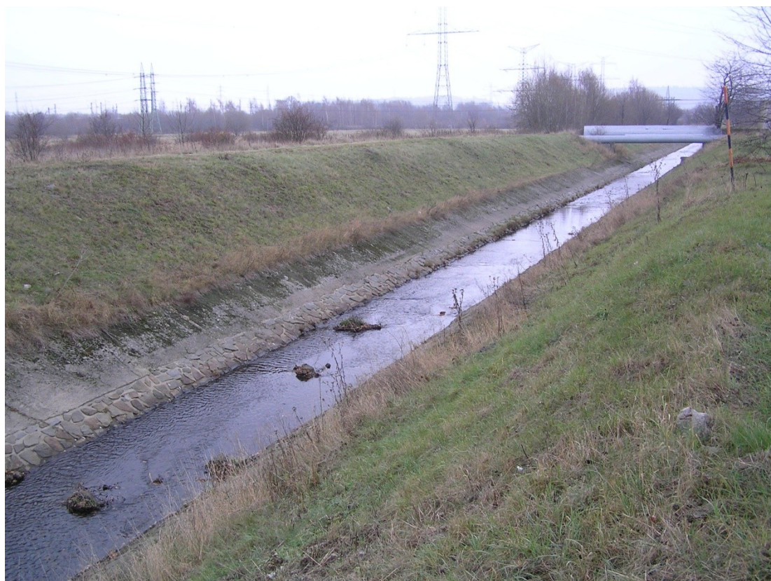
Foto 10: Upravené koryto toku v Mostecké pánvi.
