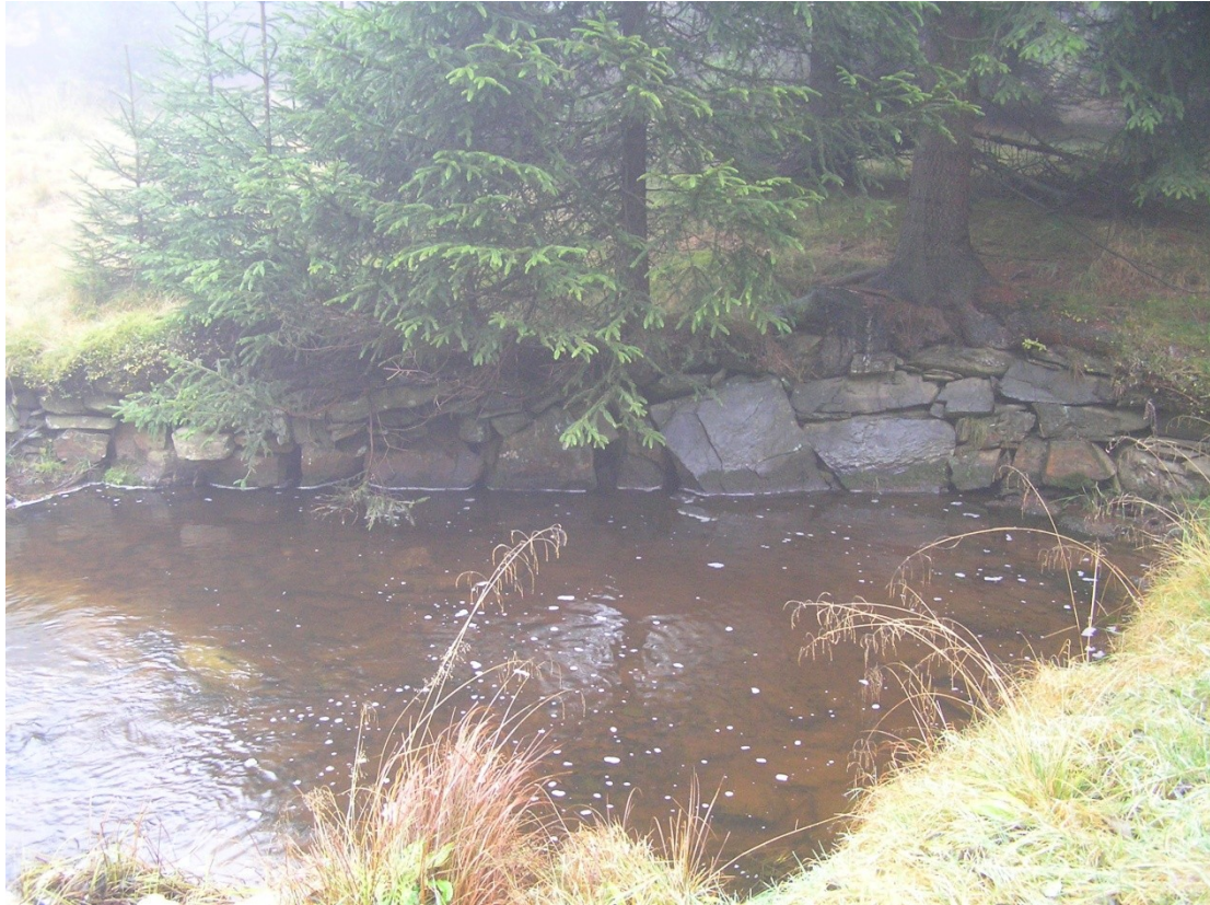
Foto 4: Zpevnění břehů kameny ve 2. úseku.
