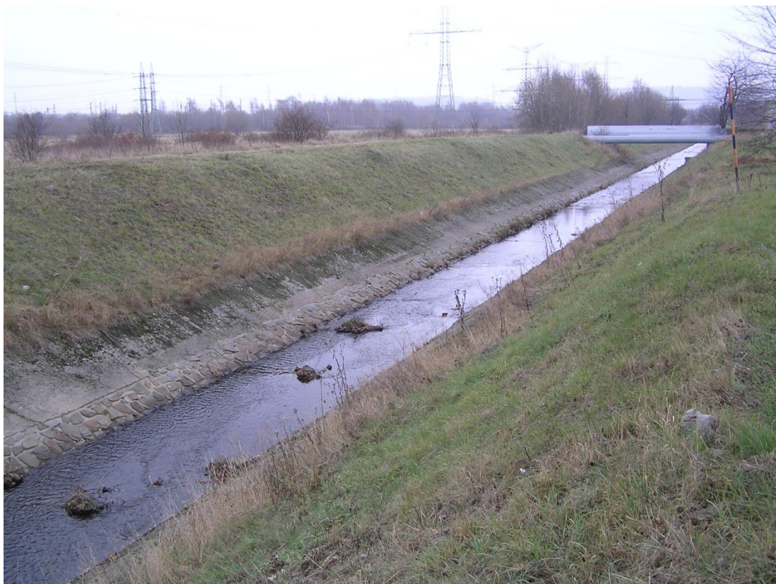
Foto 10: Upravené koryto toku v Mostecké pánvi.
