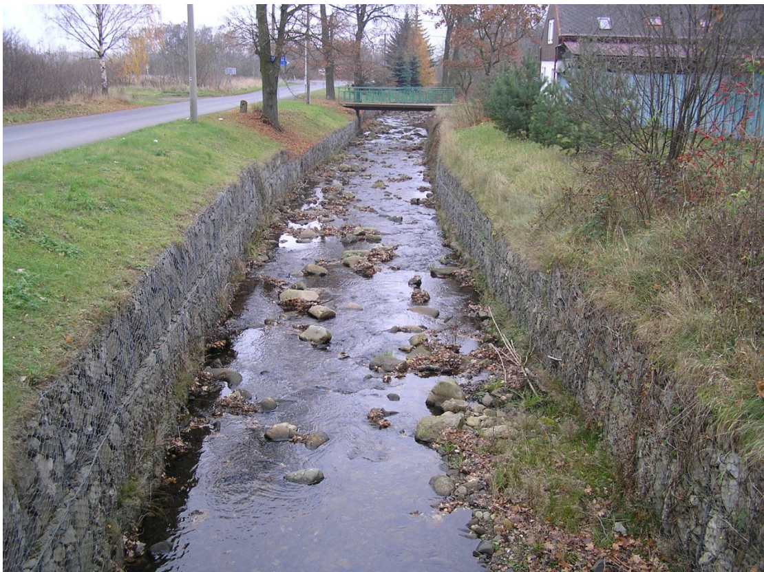
Foto 9: Zpevnění břehů potoka v Nové Vísce.
