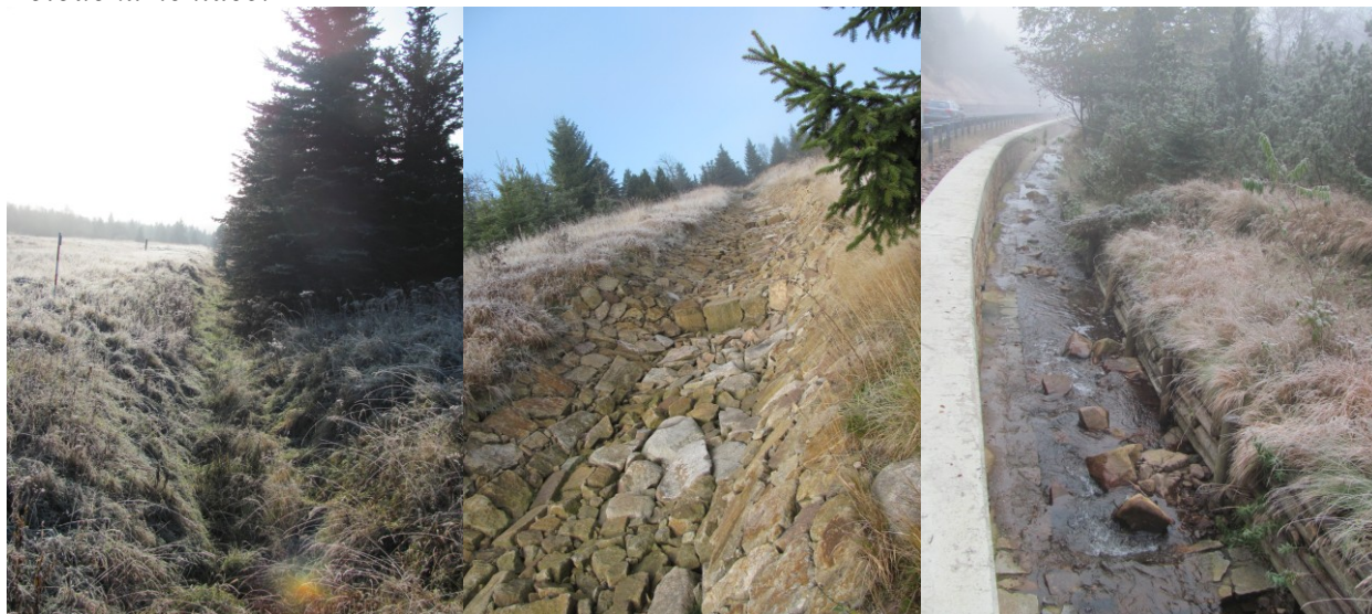
Obr. 13: Vlevo napřímená strouha toku Bystřice asi 200 m od pramene, uprostřed zpevněné koryto i dno pomocí kamenů bez pojiva v úseky 500 - 1500 m od pramene, vpravo ukázka částečně zpevněného koryta dřevěnými kůly a zdí u silnice E55).
