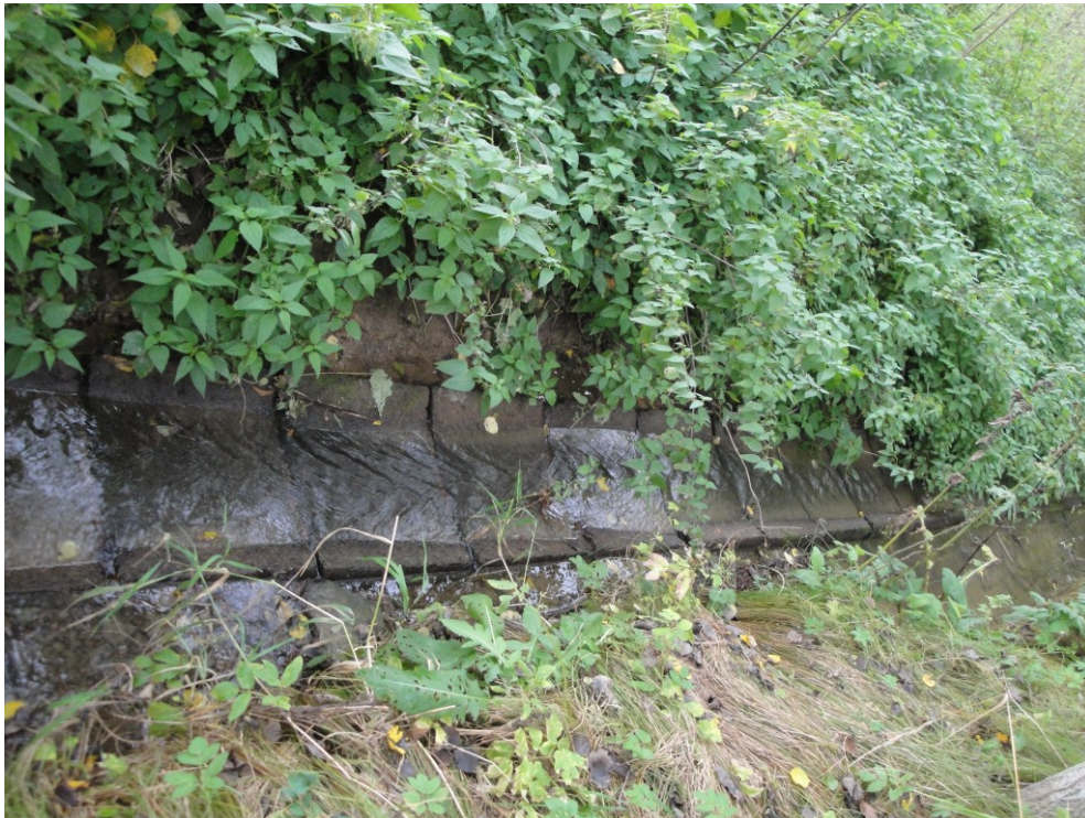
Obr.8 – Opevnění dna v korytě Končinského potoka.
