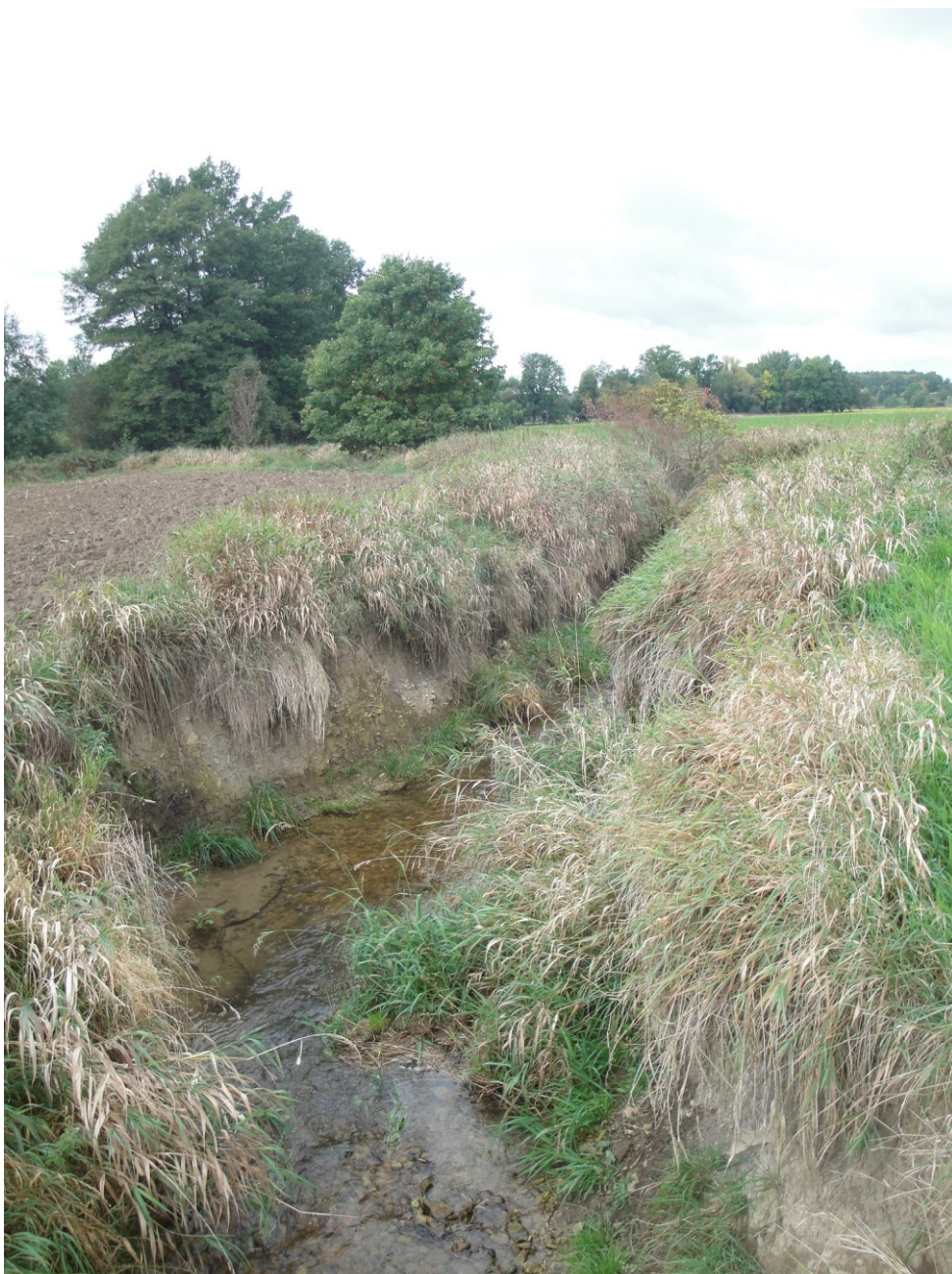
Obr.9 – Výrazné zkapacitnění koryta u obce Bohuňovice.
