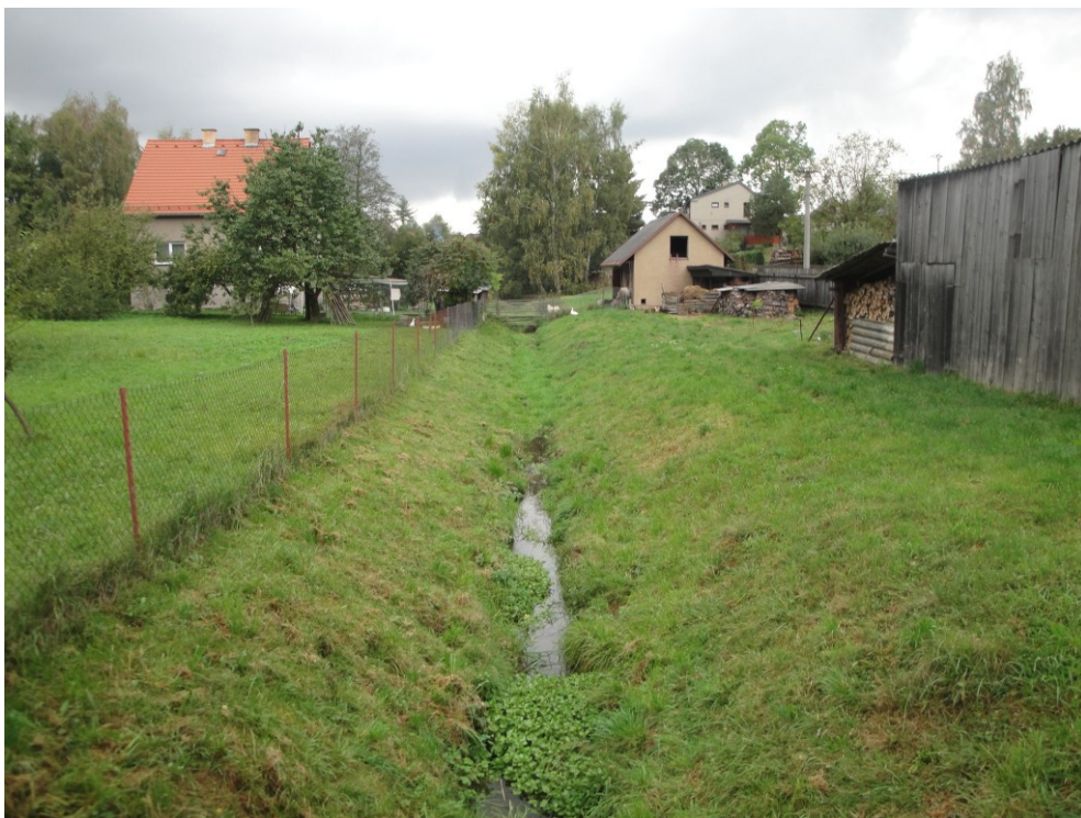
Obr.7 – Napřímení a zkapacitnění toku v obci Janov.
