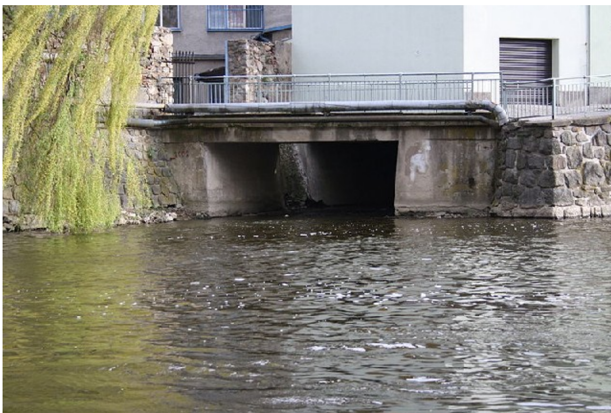
Obr. 18. Vyústění tunelu se Stařečským potokem do řeky Jihlavy v Třebíči.
