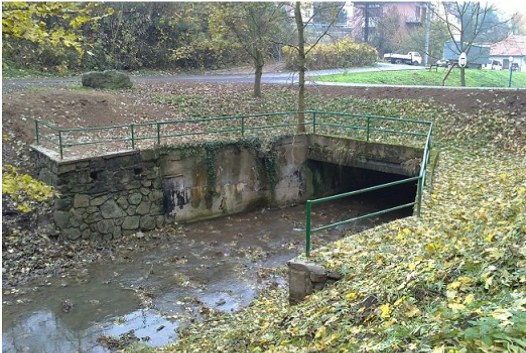
Obr. 8. Zaústění Stařečského potoka do tunelu pod městem Třebíčí.
