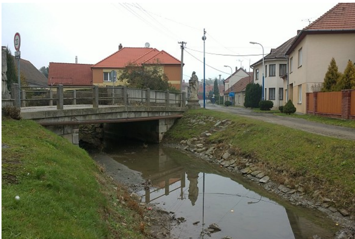
Obr. 13. Upravené koryto Stařečského potoka na počátku dolního toku v obci Stařeč.
