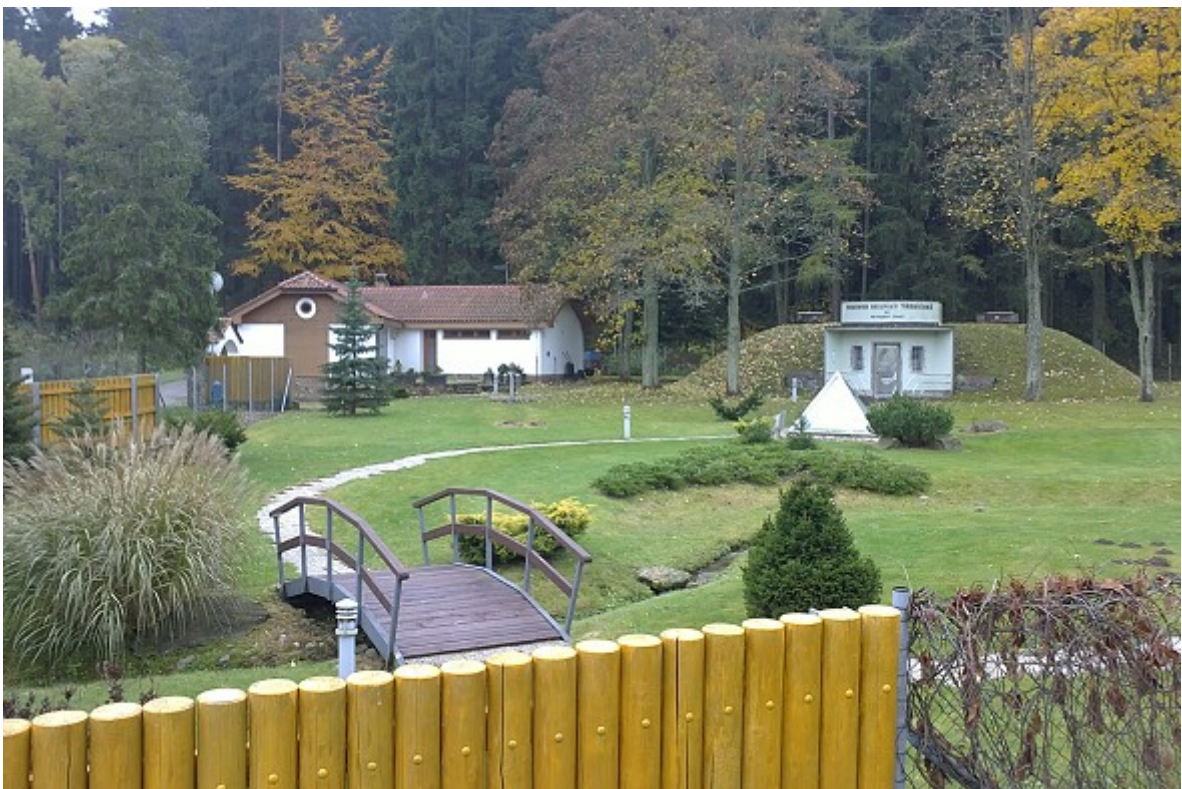
Obr. 10. Zdroj pitné vody pro město Třebíč u Heraltic na přítoku Stařečského potoka.
