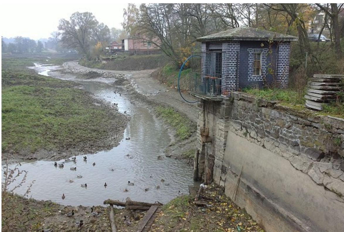
Obr. 14. Vypuštěný Borovinský rybník na okraji Třebíče na dolním toku Stařečského potoka.
