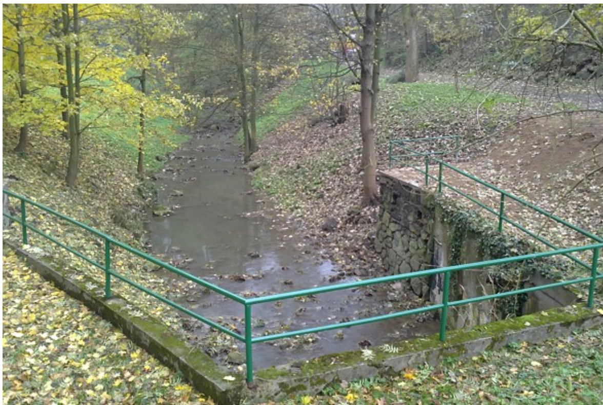
Obr. 17. Ústí Stařečského potoka do tunelu pod Třebíčí na dolním toku, přibližně 600 metrů před ústím do Jihlavy.
