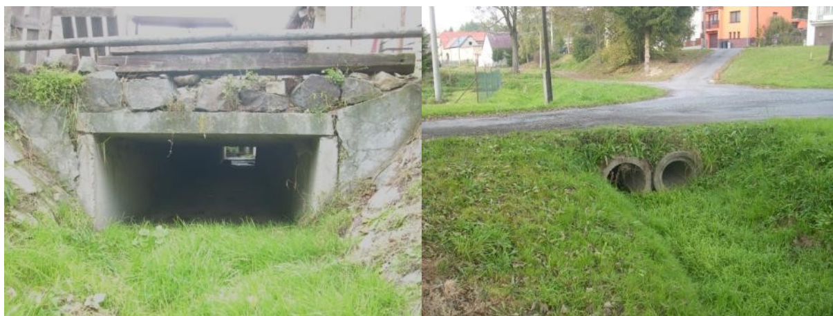
Obr. 7, 8 Betonové tvárnice a skruže v obci Koclířov
