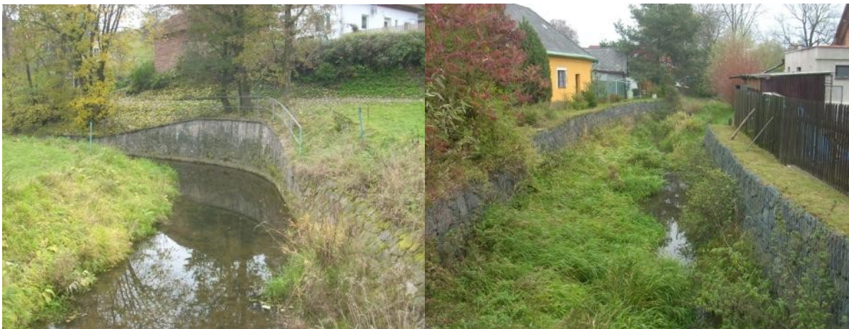
Obr. 10, 11 Břehové opevnění v Opatově: Betonová zeď a gabiony
