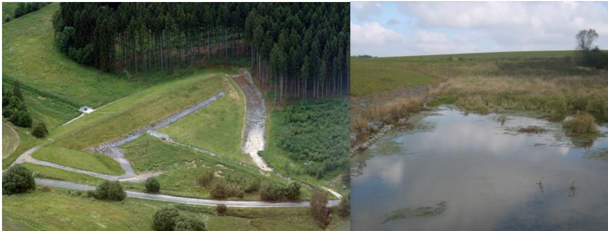
Obr. 15, 16 Suchý poldr č. 2; nadržení vody u poldru č. 1
