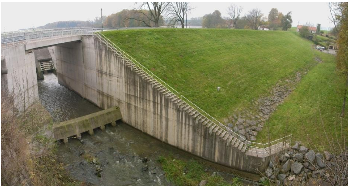
Obr. 18 Rybník Hvězda: nově zrekonstruovaná hráz a sdružený objekt s přepadem vody a vývarem pod ním
