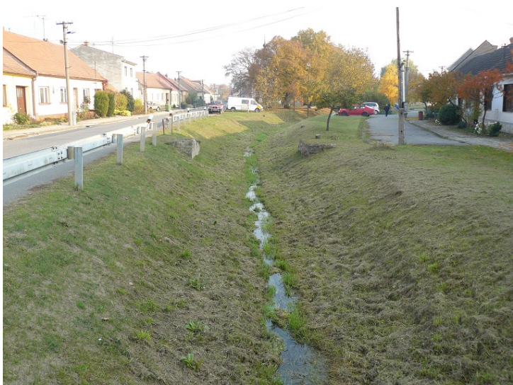
Obr. 9: Šatava v Mělčanech, zkapacitněné koryto, vysekávaný travinný dm
