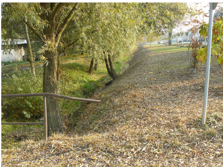
Obr. 8: Lejtna v Bratčicích, zkapacitněné koryto
