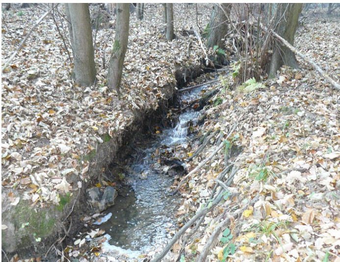
Obr. 17: Drobnější stupně v korytě, břehové nátrže
