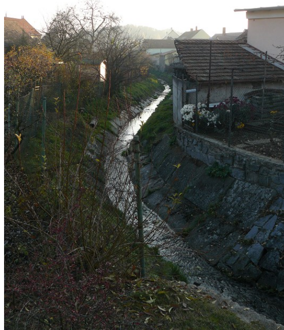
Obr. 13: Koryto opevněné betonovými panely a dlaždicemi v celém svém profilu, typický tvar lichoběžníku (Prštice)
