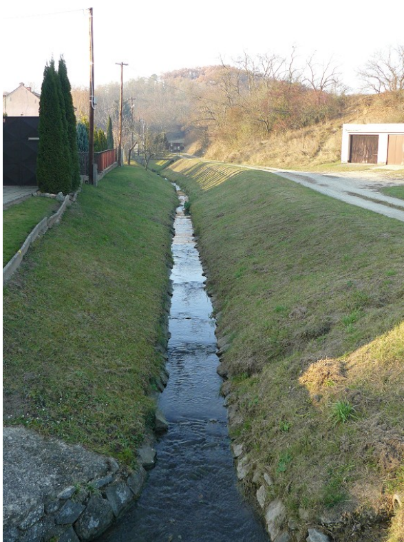
Obr. 12: Opevněná pata koryta v Pršticích
