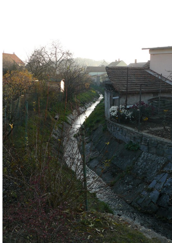
Obr. 13: Koryto opevněné betonovými panely v celém svém profilu (Prštice)
