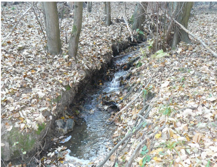
Obr. 17: Drobnější stupně v korytě, břehové nátrže
