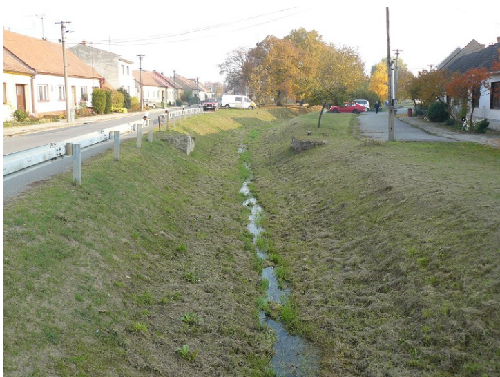
Obr. 9: Šatava v Mělčanech, zkapacitněné koryto
