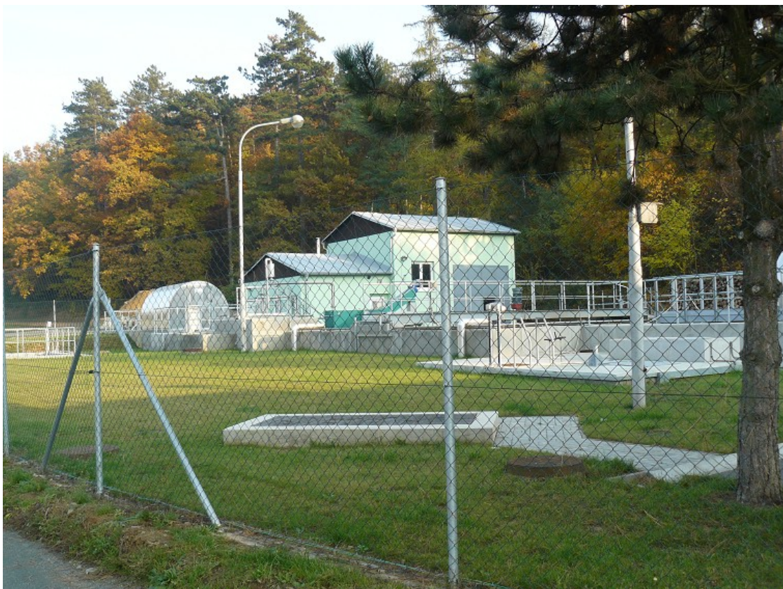
Obr. 11: Areál ČOV Silůvky
